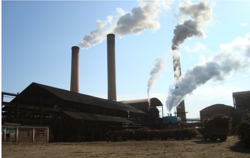
Figura 3.1- Usina Coagro, localizada no Município de Campos dos Goytacazes/RJ.
