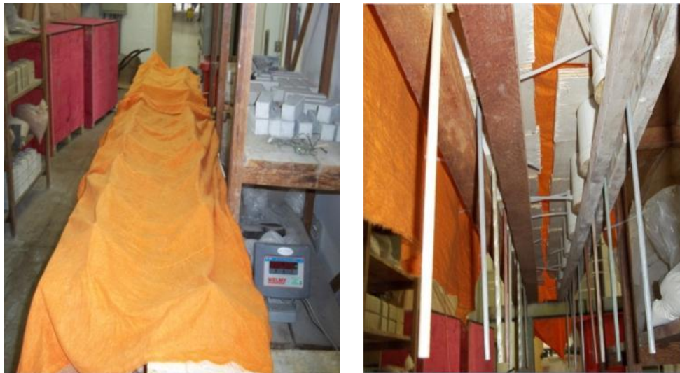
Figura 3.30 – Primeiro dia após concretagem dos corpos de prova
