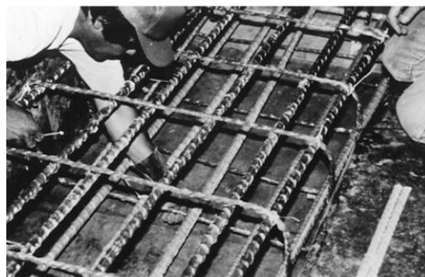
Figura 2.4 - Montagem da armadura de PRFV (ACI 440R, 1996).
