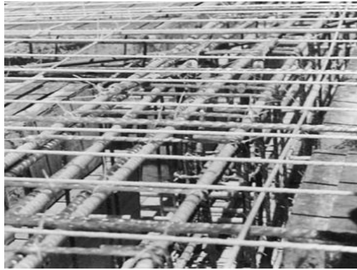
Figura 2.5 - Armaduras de PRF utilizadas em hospitais de MRI (ACI 440R, 1996).
