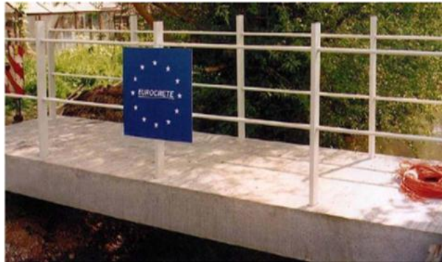
Figura 2.10 - A primeira passarela de concreto somente com armadura de PRFV (FIB – TASK GROUP 9.3, 2007).
