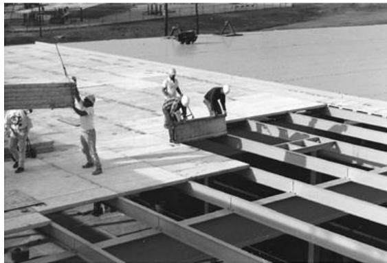
Figura 2.8 - Colocação de lajes pré-moldadas, Atlanta, Geórgia (ACI 440R, 1996).
