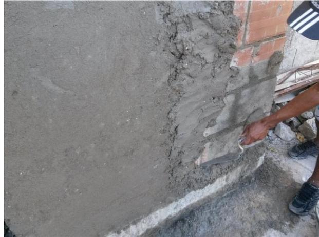
Figura 4.4 – Execução do revestimento em massa única.
