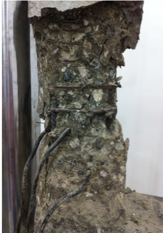
Figura 4.49– Padrão de ruptura do pilar P2-60-4,2-30.
