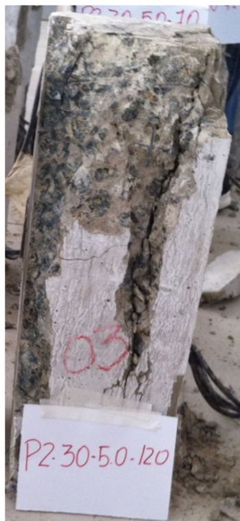
Figura 4.74– Padrão de ruptura do pilar P2-30-5,0-120.
