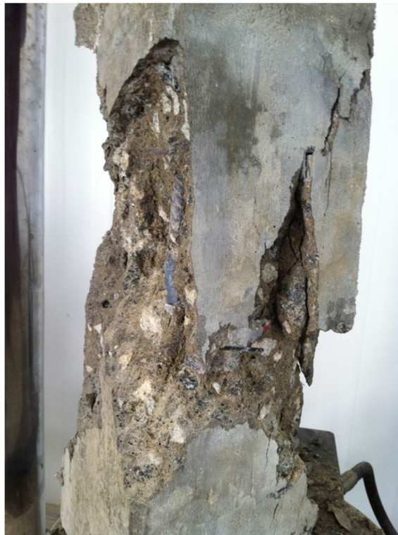
Figura 4.42– Padrão de ruptura final do pilar P1-60-5,0-120.
