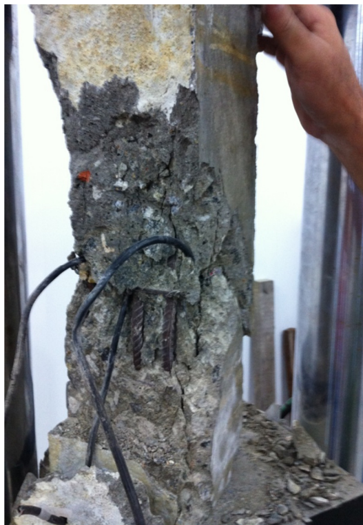
Figura 4.57– Padrão de ruptura do pilar P2-60-4,2-70.
