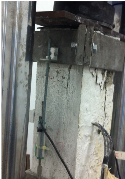
Figura 4.50– Padrão de ruptura do pilar P2-30-5,0-30.
