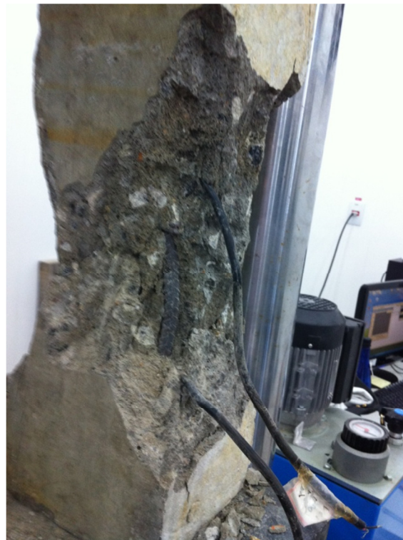
Figura 4.40– Padrão de ruptura final do pilar P1-60-4,2-120.
