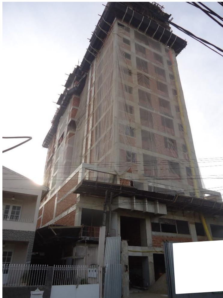
Figura 4. 9 - Vista Externa do Edifício 2.
