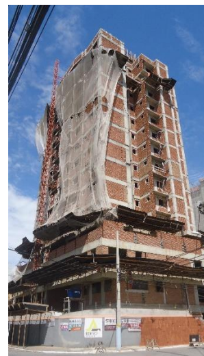
l) 633º dia de construção - 26ª medição
