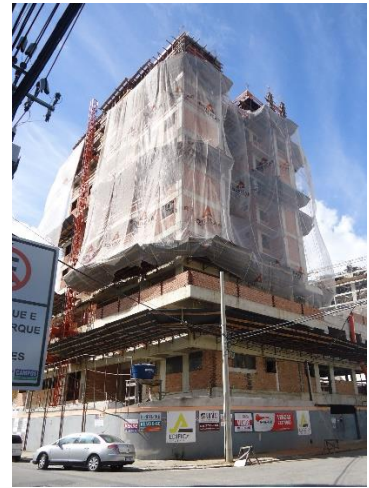
f) 424º dia de construção - 12ª medição
