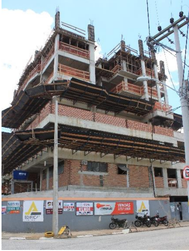
a) 306º dia de construção – 1ª medição
