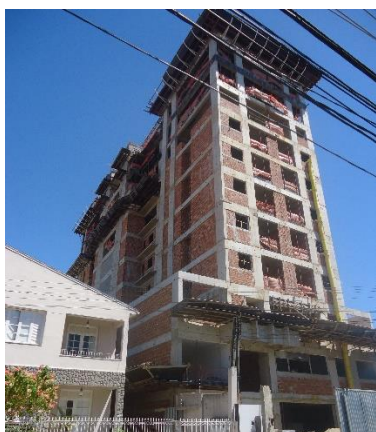
a) 600º dias de construção – 2ª medição
