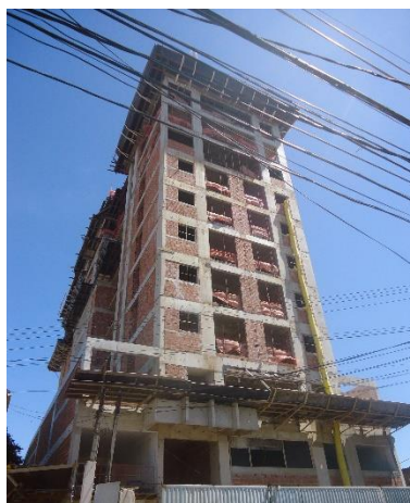
b) 621º dias de construção – 4ª medição
