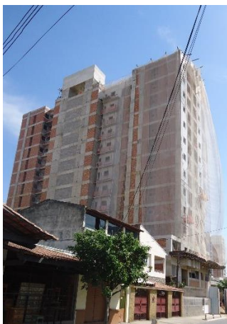
g) 789º dias de construção – 24ª medição
