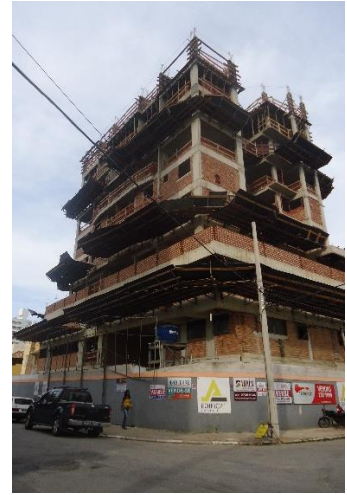
c) 361º dia de construção – 7ª medição
