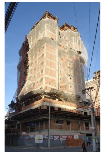
i) 529º dia de construção – 18ª medição
