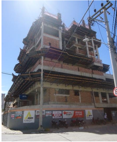
b) 339º dia de construção – 3ª medição
