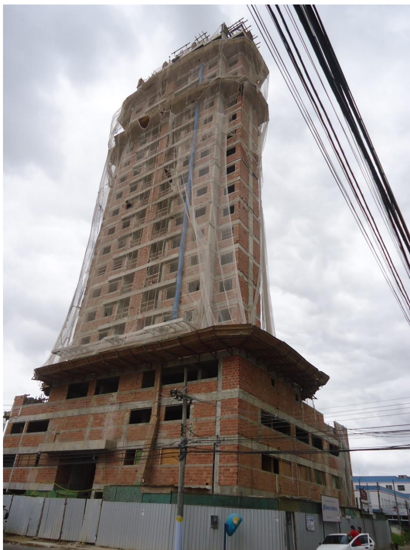
Figura 4. 14 - Vista externa do Edifício 3
