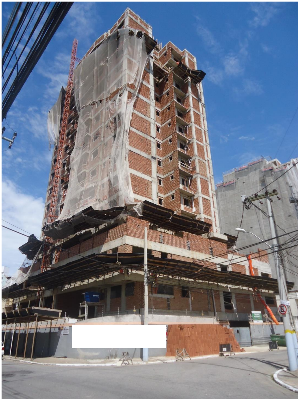
Figura 4. 4 - Vista Externa do Edifício 1.
