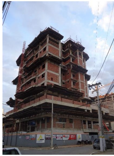
e) 411º dia de construção – 11ª medição
