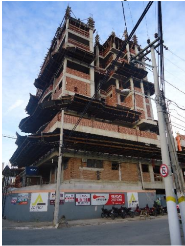
d) 389º dia de construção - 9ª medição
