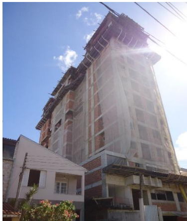
d) 691º dias de construção – 13ª medição
