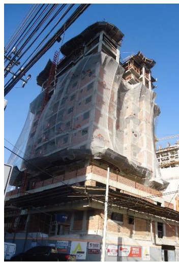
h) 482º dia de construção – 15ª medição
