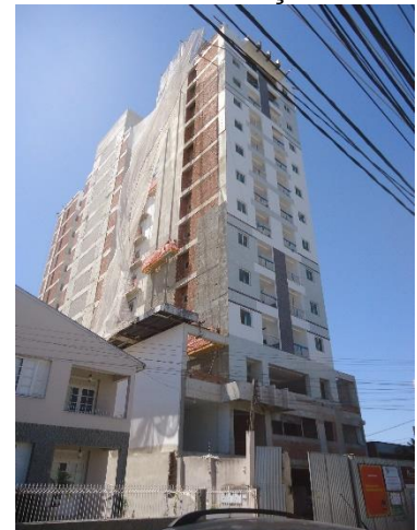
i) 919º dias de construção – 34ª medição
