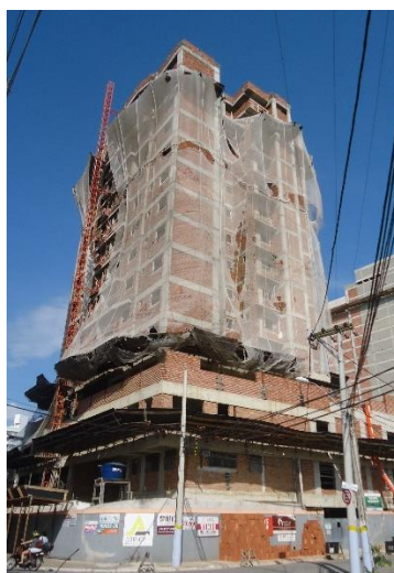
k) 578º dia de construção - 22ª medição
