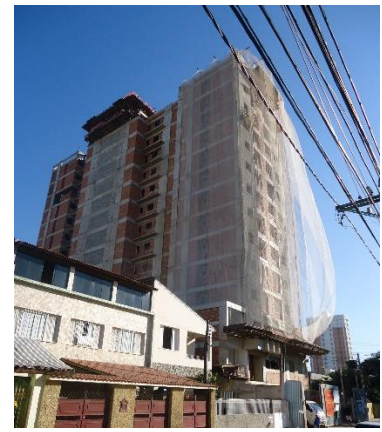
f) 755º dias de construção – 19ª medição
