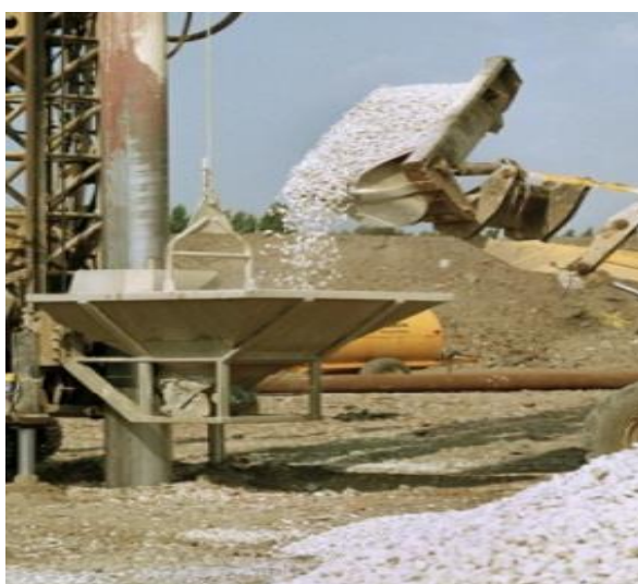
Figura 9: Enchimento da caçamba, primeira etapa do processo de construção de colunas de brita pela técnica de vibrosubstituição (Keller Brasil, 2014).
