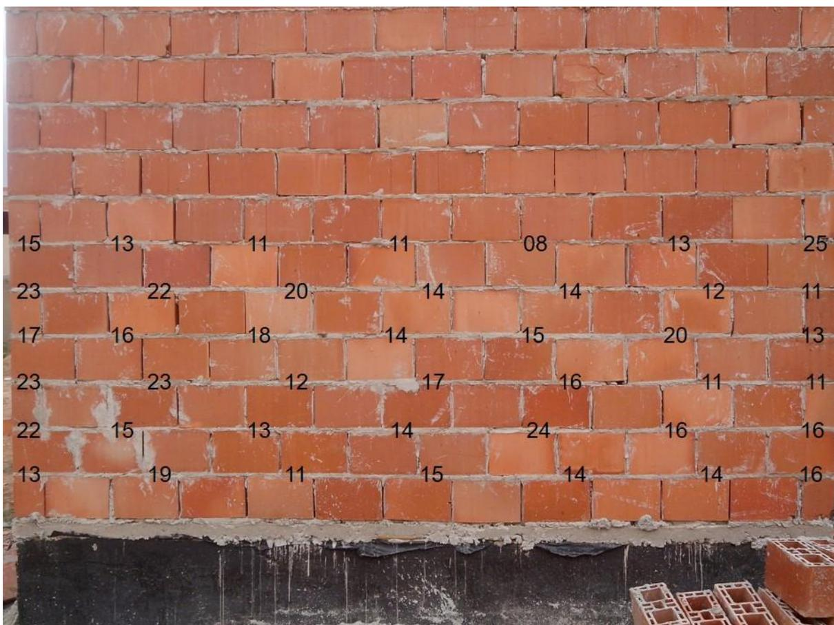
Figura 1.1 – Parede em alvenaria estrutural com os valores das juntas horizontais.
