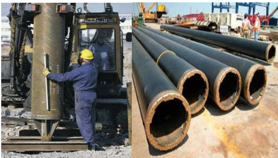
Figura 2.1– Estacas tubulares vazadas de aço de ponta fechada e ponta aberta (Bhushan, 2004).
