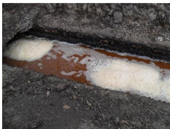
Figura 2.6 – Calha de escoamento de vinhoto.
