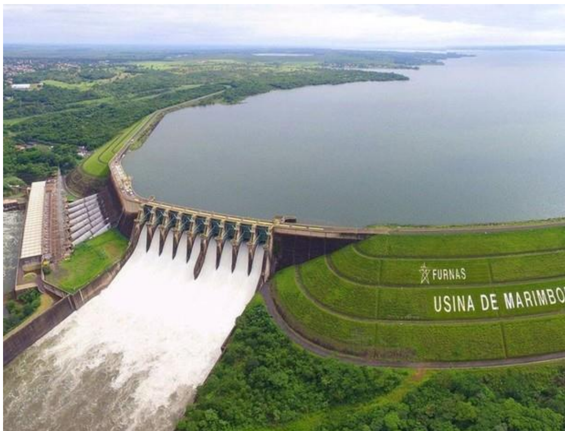
Figura 3.11 – Usina Hidrelétrica de Marimbondo.
