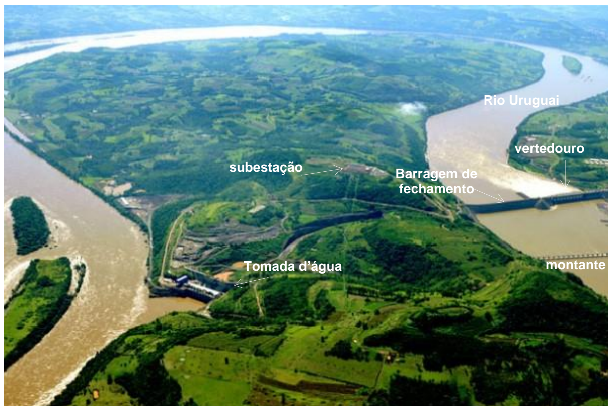
Figura 3.18 – Vista superior da UHE Foz do Chapecó. (Fonte: www.fozdochapeco.com.br/banco de imagens , acesso em 14/05/2016)
