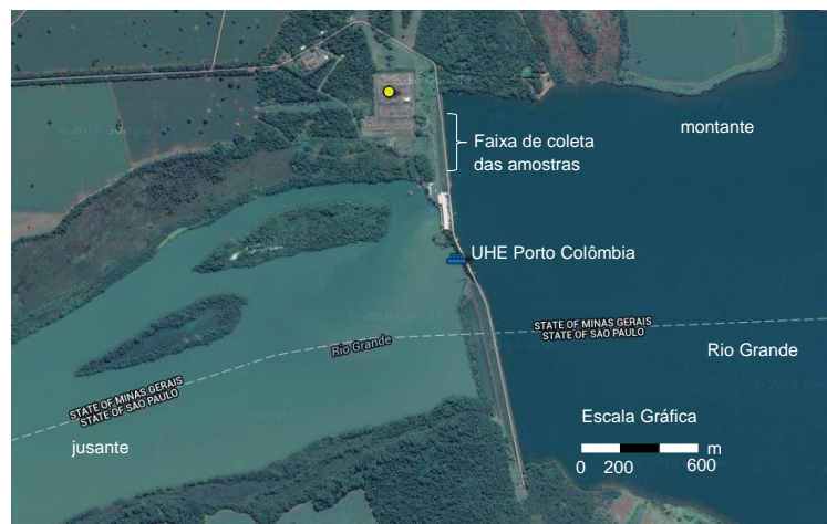
Figura 3.9 – Vista Superior da UHE de Porto Colômbia
