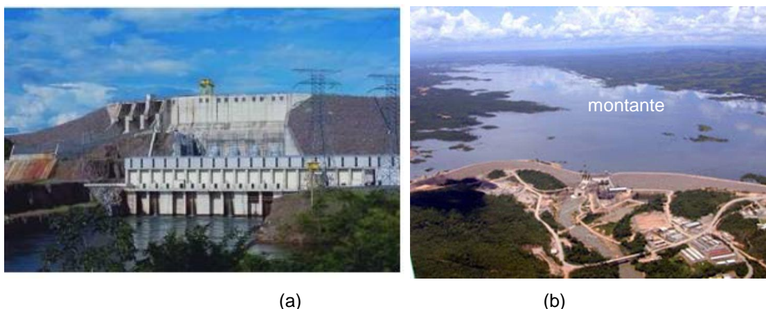
Figura 3.15 – (a) Vista frontal à jusante; (b) vista superior, UHE de Manso. (fonte: www.camarachapadadosguimaraes.mt.gov.br , acesso em 01/07/2016)
