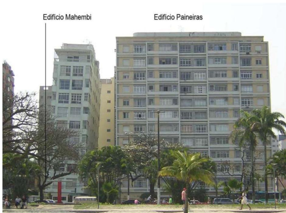
Figura 25 – Santos – SP - Edifício Maembi a esquerda da foto, inclinado em direção ao edifício Paineiras, à direita (Dias, 2010)
