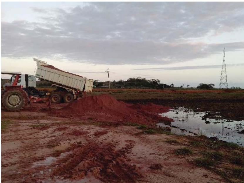
Figura 42 - Construção do acesso para as máquinas
