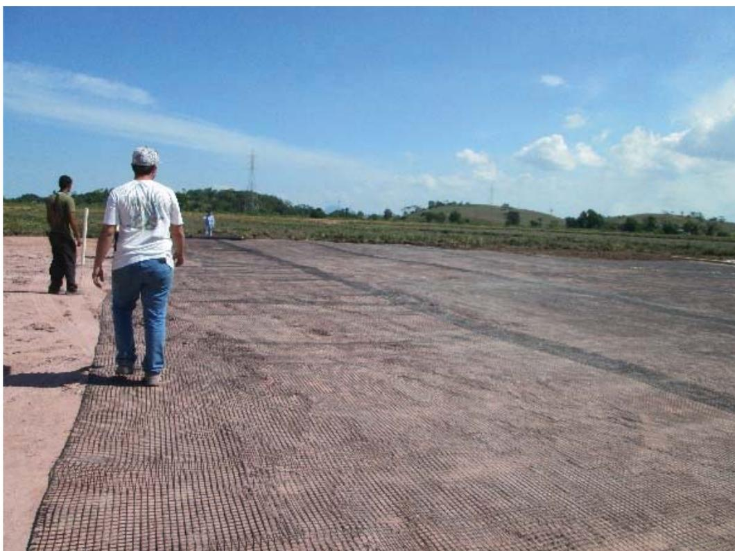
Figura 47- Finalização da instalação da Geogrelha
