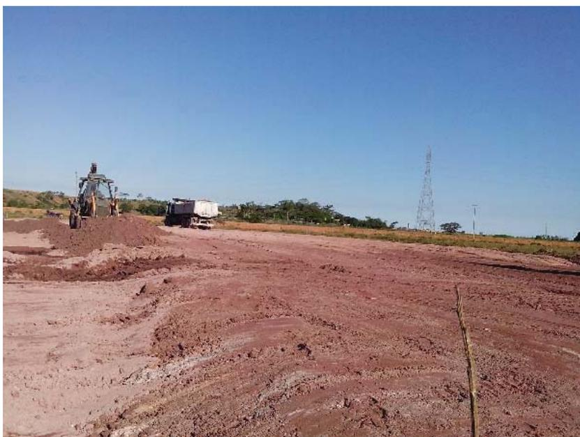
Figura 43 - Finalização da construção da camada drenante
