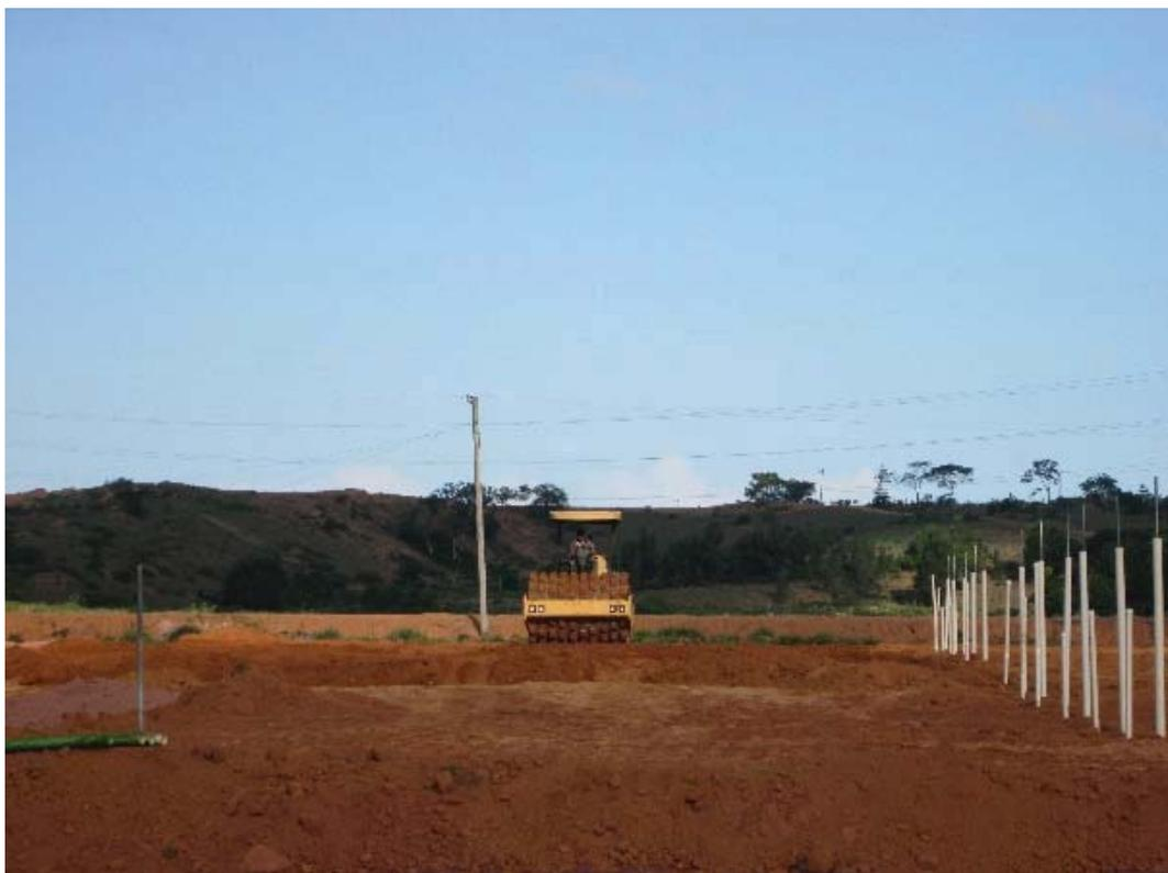
Figura 52 – Compactação da 3ª camada do aterro
