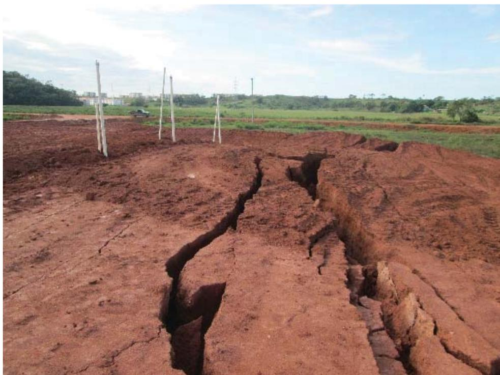
Figura 54 - Ruptura do Aterro 2
