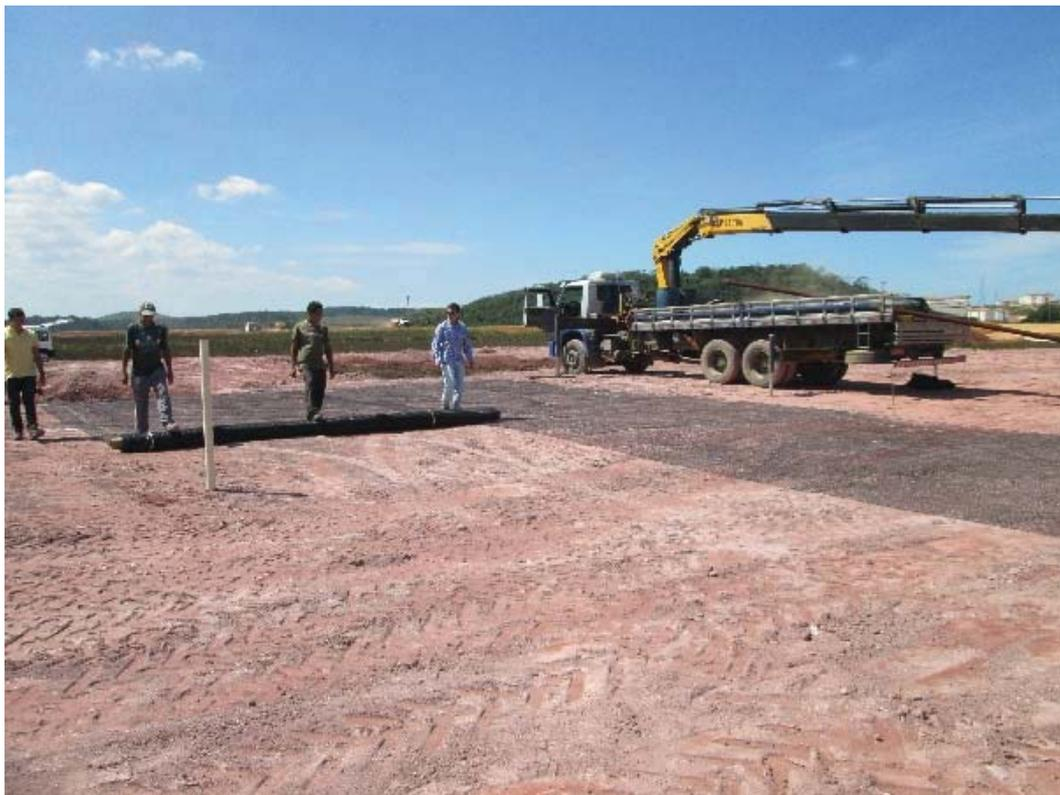
Figura 46- Instalação da Geogrelha
