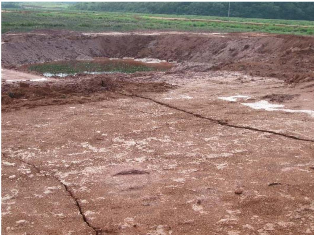
Figura 59 - Trincas transversais no Aterro 1
