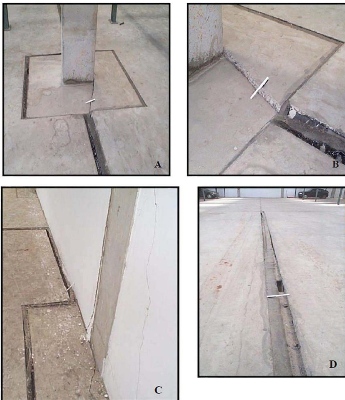
*Figura 30 – Galpão – PE - A, B – Abertura das juntas do piso próximo ao pilar; C – Detalhe do afundamento do bloco e deslocamento do piso; D – Detalhe da abertura das juntas do piso (Bello, 2004)*
