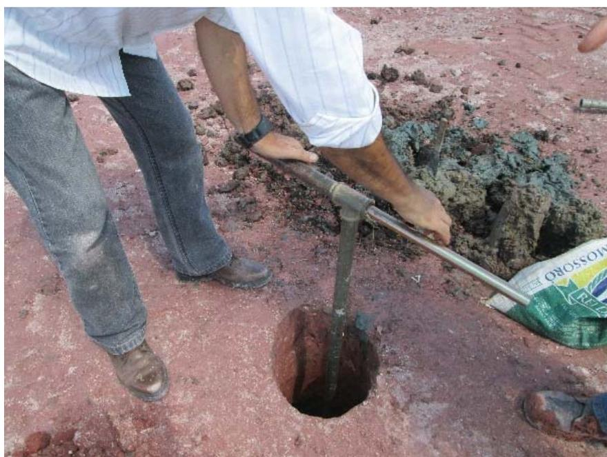
Figura 44 - Perfuração a trado para instalação do piezômetro
