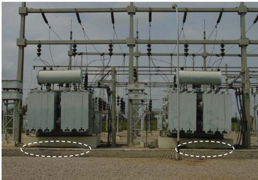
*Figura 26 – Subestação de Linhas de Transmissão da Light – RJ - Geradores mostrando tendências a tombamento, com trincas horizontais na base dos coroamentos das fundações (Campos, 2006)*
