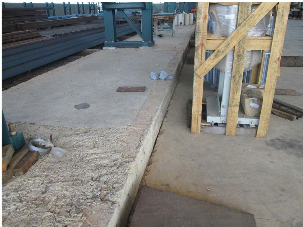
*Figura 28 – Galpão Macaé - Desnível acentuado entre as lajes internas e os blocos de fundação dos pilares de estrutura metálica (Póvoa, 2016)*
