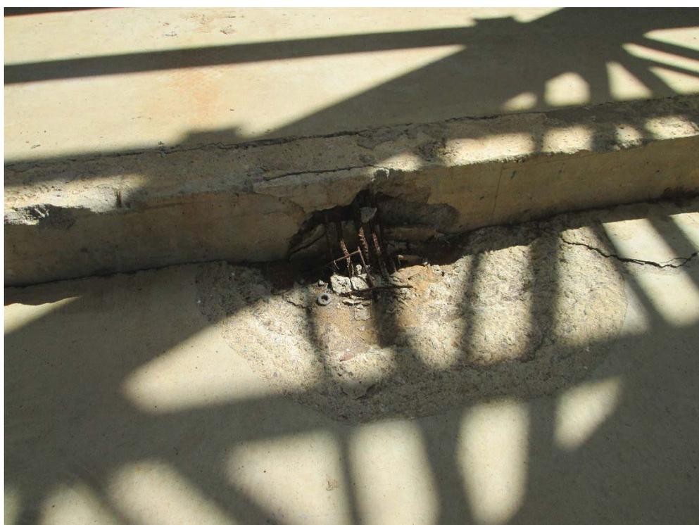
*Figura 29 – Galpão Macaé - Ruptura de elementos de ligação entre as lajes internas e os blocos de fundação dos pilares da estrutura metálica (Póvoa, 2016)*
