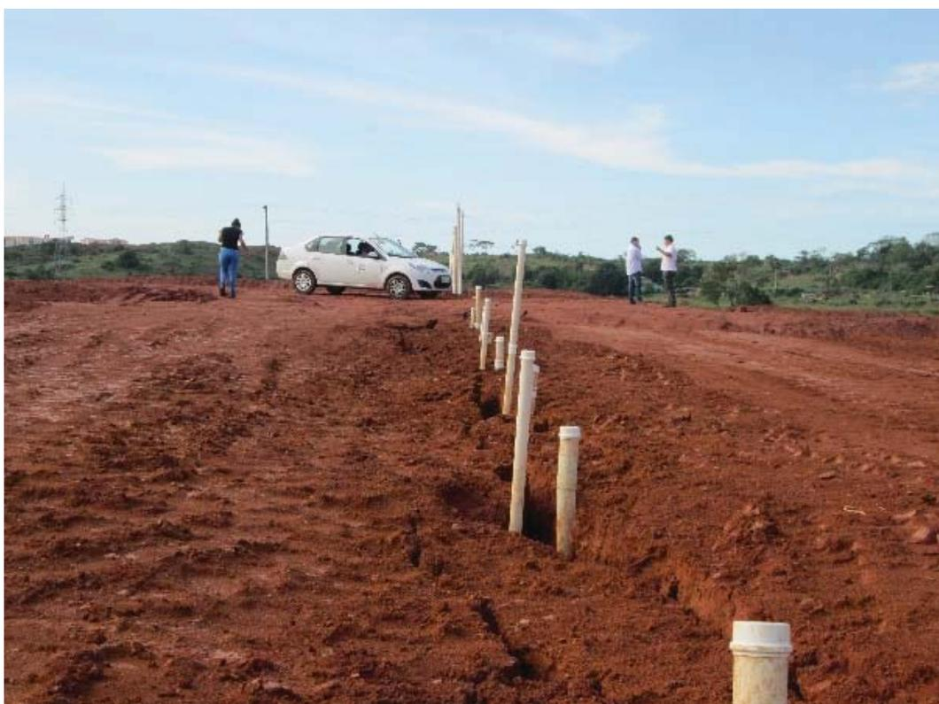
Figura 58 - Trincas longitudinal no Aterro 1
