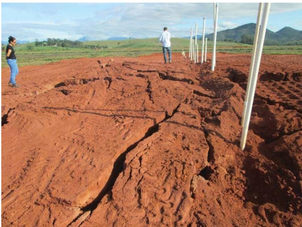
Figura 56 - Ruptura do Aterro 2 – desvio das trincas
