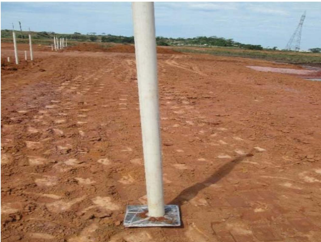
Figura 48 - placa de recalque já com o tubo PVC
