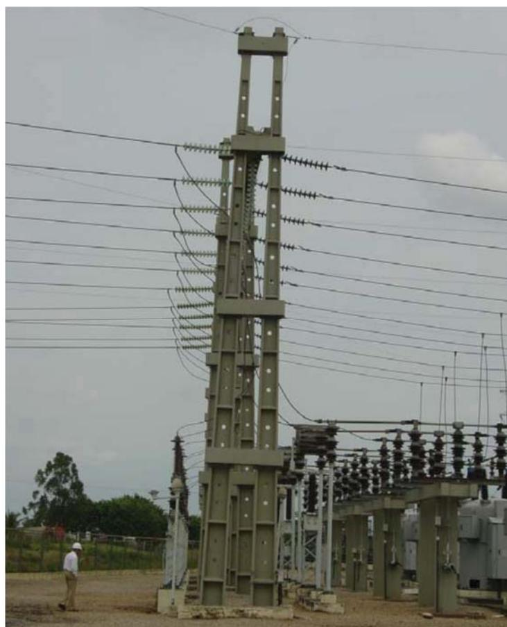
*Figura 27 - Subestação de Linhas de Transmissão da Light – RJ - Distorções de pórticos (Campos, 2006)*
