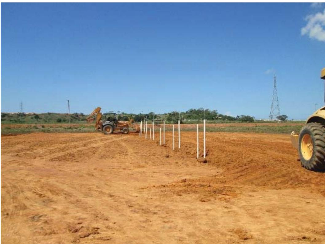
Figura 51 - Compactação da 2ª camada do aterro
