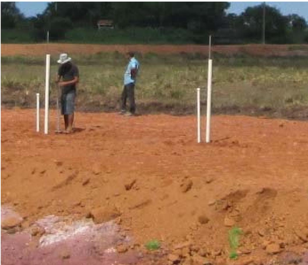
Figura 50 - Detalhe da compactação manual entre os piezômetros e as placas de recalque
