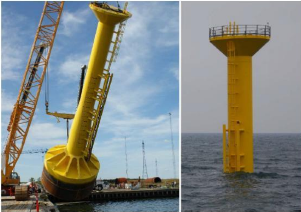
Figura 2.1. Estaca de sucção para Met Mast instalada Horn Rev 3 Offshore Wind Farm, Dinamarca (LeBlanc 2004).
