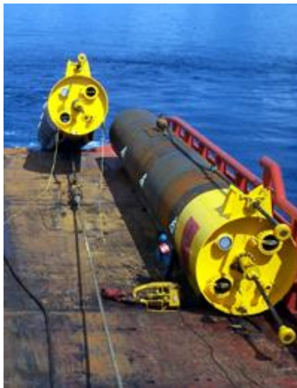
Figura 2.2- Instalação por rebocador ( http://www.delmarus.com/ ).
