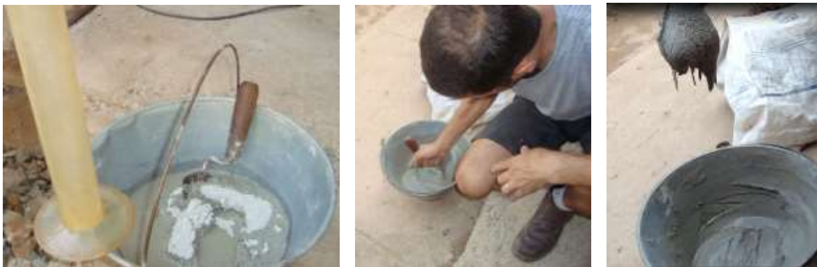
Figura 3-30: Preparação da pasta de cimento para capeamento dos blocos.
