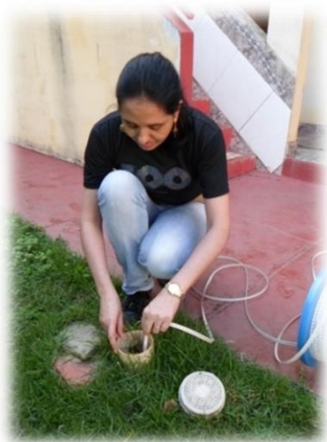
Figura 6.1. Poço raso com revestimento de PVC com tampa.
