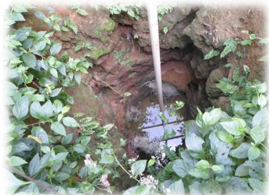
Figura 6.40. Poço sem vedação
