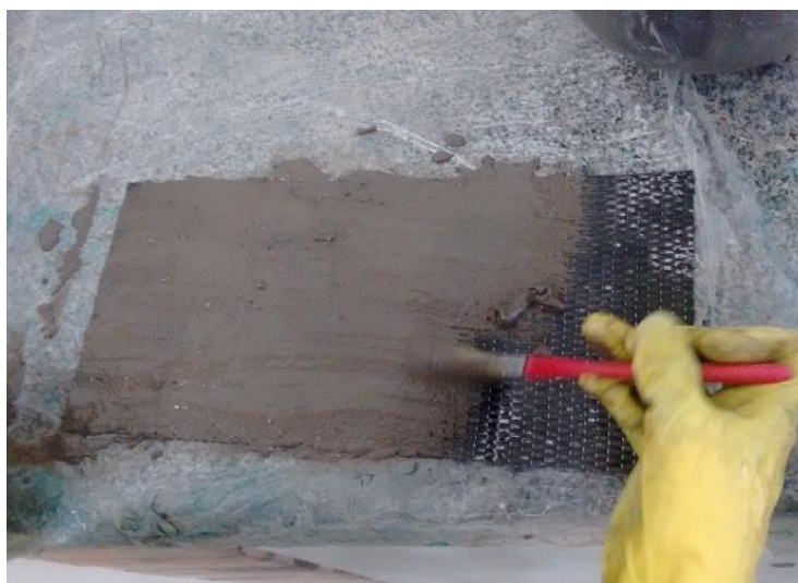
Figura 4.13 - Realização do sistema com uma camada de reforço com compósito de fibra de carbono e resina geopolimérica (continua).
