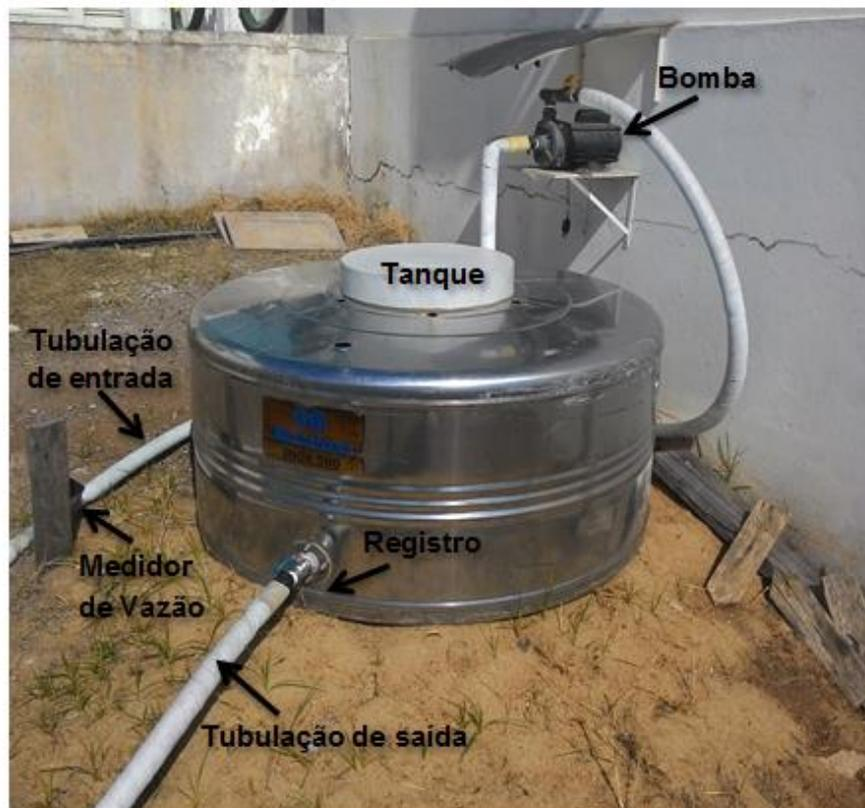
Figura 32: Equipamentos instalados para a realização do T.R.T.
