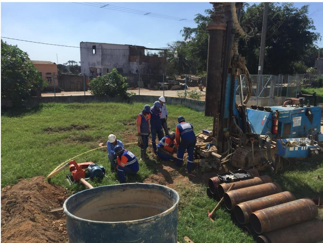
Figura 30: Execução da estaca geotérmica.
