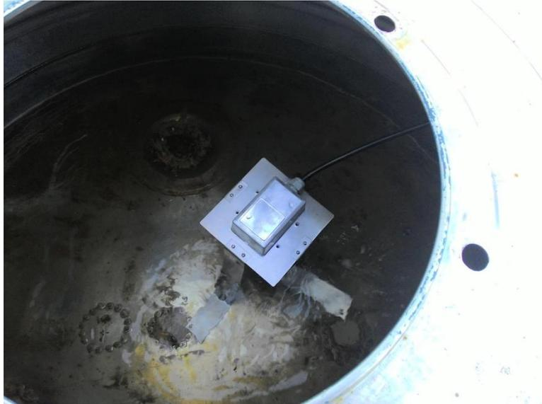
Figura 35: Resistência de imersão instalada no interior do tanque.
