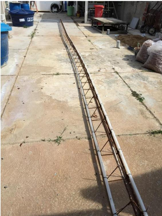
Figura 22: Tubo PEX trocador de calor preso à armadura da estaca.
