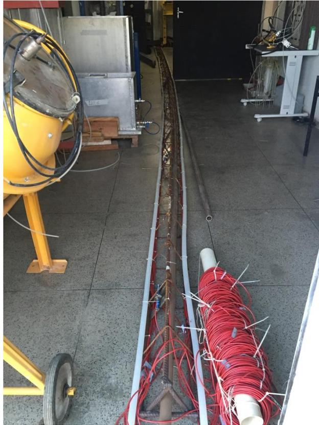
Figura 29: Armadura, tubulação trocadora de calor e sensores prontos para serem inseridos na estaca.
