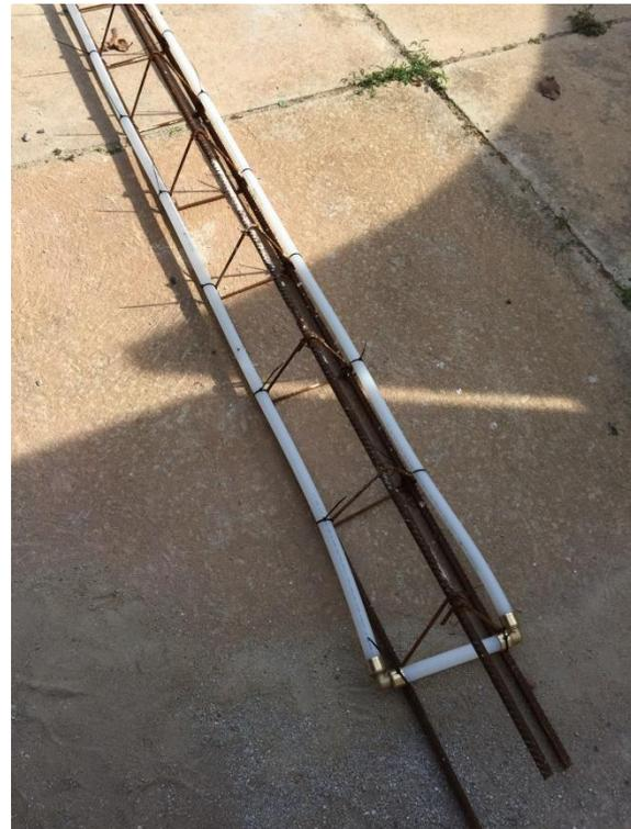
Figura 23: Detalhe da conexão entre as tubulações de entrada e de saída.
