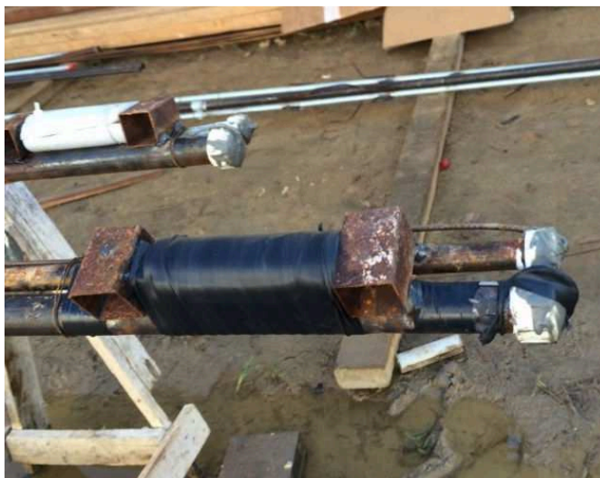
Figura 21 – Fotografia do medidor de deformação instalado a 18 m de profundidade após isolamento com espuma, fita de auto fusão, e fita isolante.
