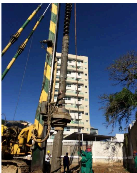
Figura 15 - Introdução do dispositivo instante após a execução da estaca.
