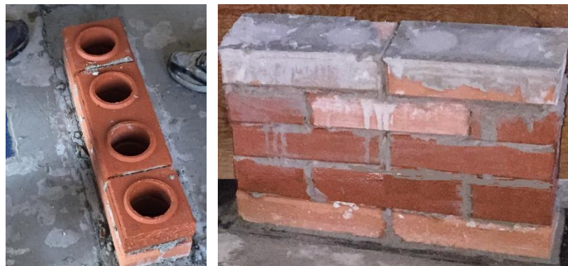
Figura 3.19 – Construção das pequenas paredes (modelo PPCA)
