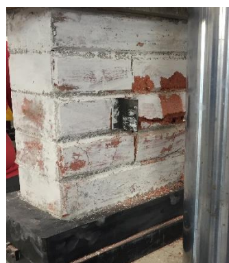
Figura G.16 – Prisma 5ISA 2 rompido
