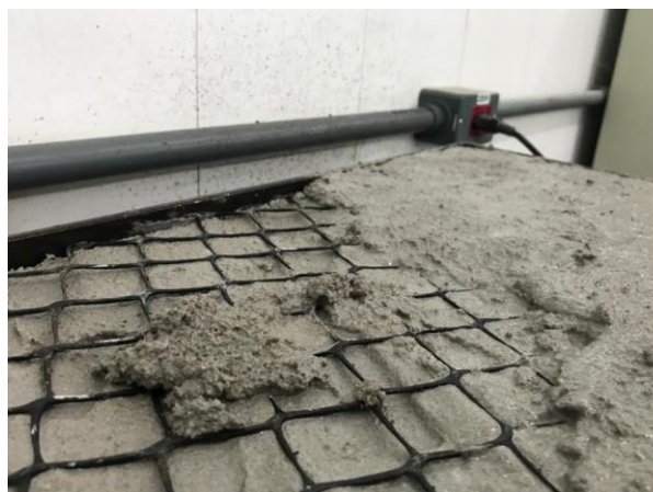
Fig. 3.4 – Exemplo do processo de moldagem da placa cimentícias. FONTE: Próprio Autor
