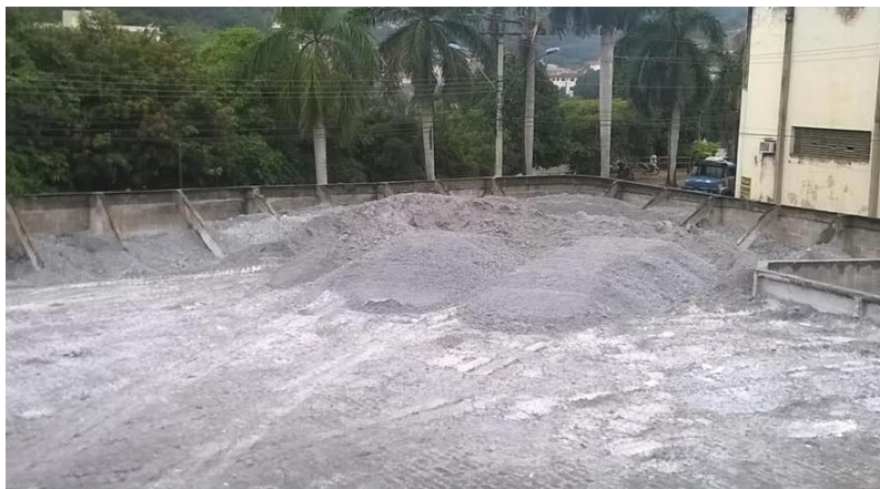
Fig. 2.4 - Vista de uma estação de tratamento de efluentes de uma indústria de papel de celulose.
