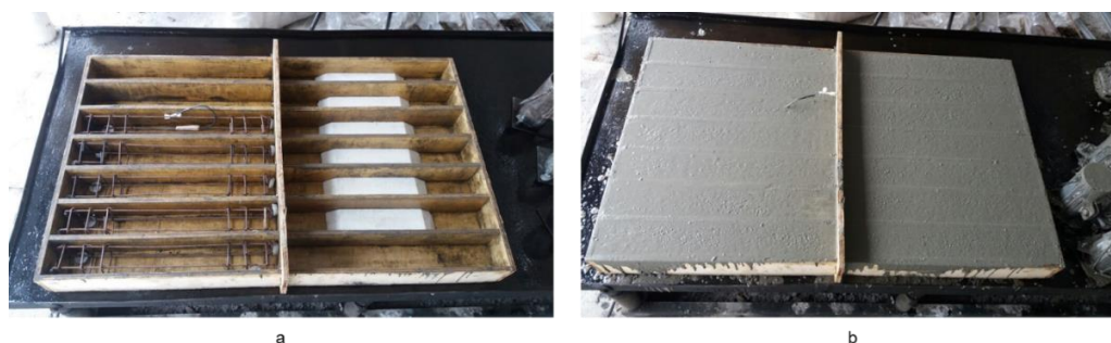
Figura 3.43 - (a) fôrma pronta para concretagem das vigas; (b) aspecto físico das vigas logo após a moldagem na segunda concretagem.
