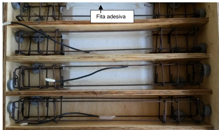
Figura 3.37 - Detalhe das fitas adesivas coladas para vedar a região de aplicação das argamassas de reparo.
