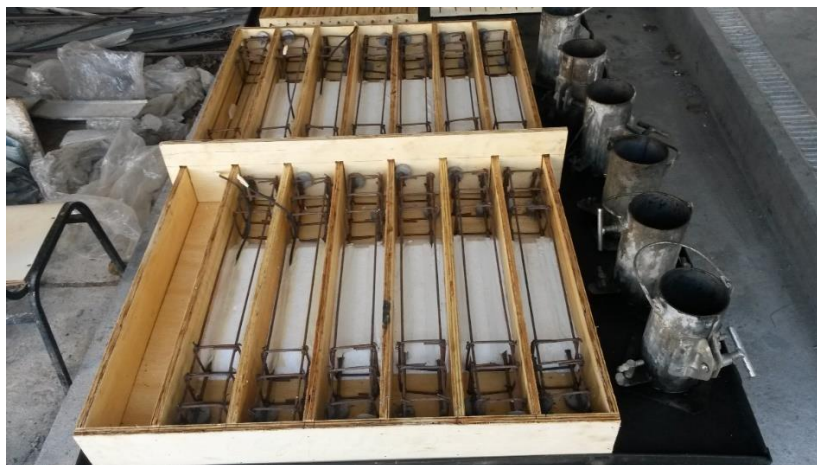
Figura 3.38 - Fôrmas das vigas prontas para receber o concreto.
