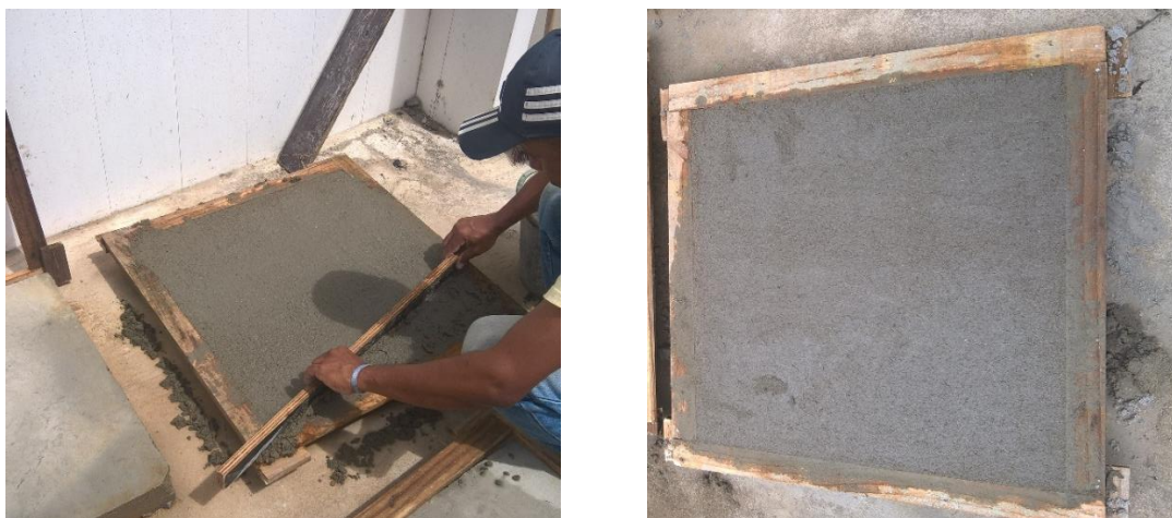
Figura 13 - Sarrafeamento do contrapiso utilizando a forma como talisca.
