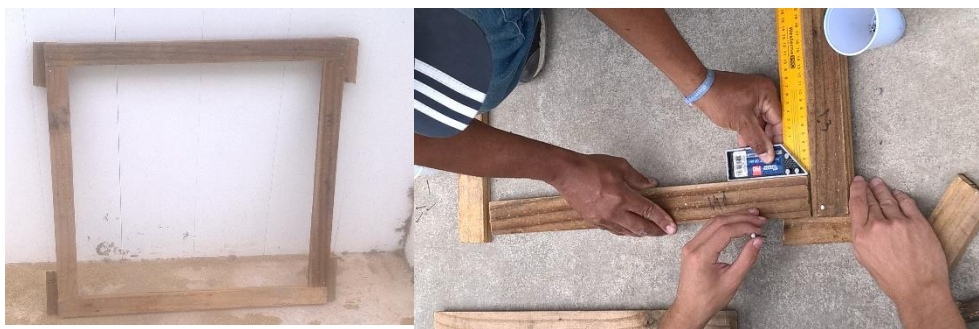
Figura 11 - Construção da forma padronizada para o contrapiso.
