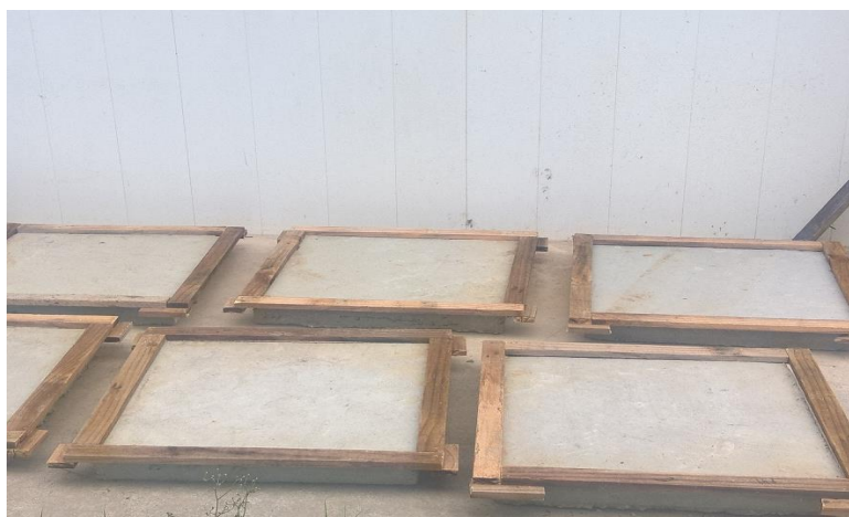
Figura 12 - Formas de madeira de mesmo padrão sobre placas de concreto à espera da argamassa.
