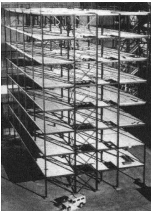
Figura 1.4: Estrutura de oito pavimentos construída em escala real (WANG, 2002).
