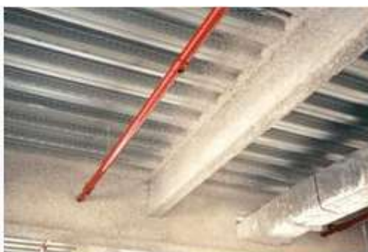
Figura 3.10: Viga mista revestida por argamassa projetada (PANNONI, 2017)
