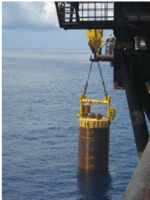
Figura 2.25: Estaca de sucção (Kawasaki, 2010).
