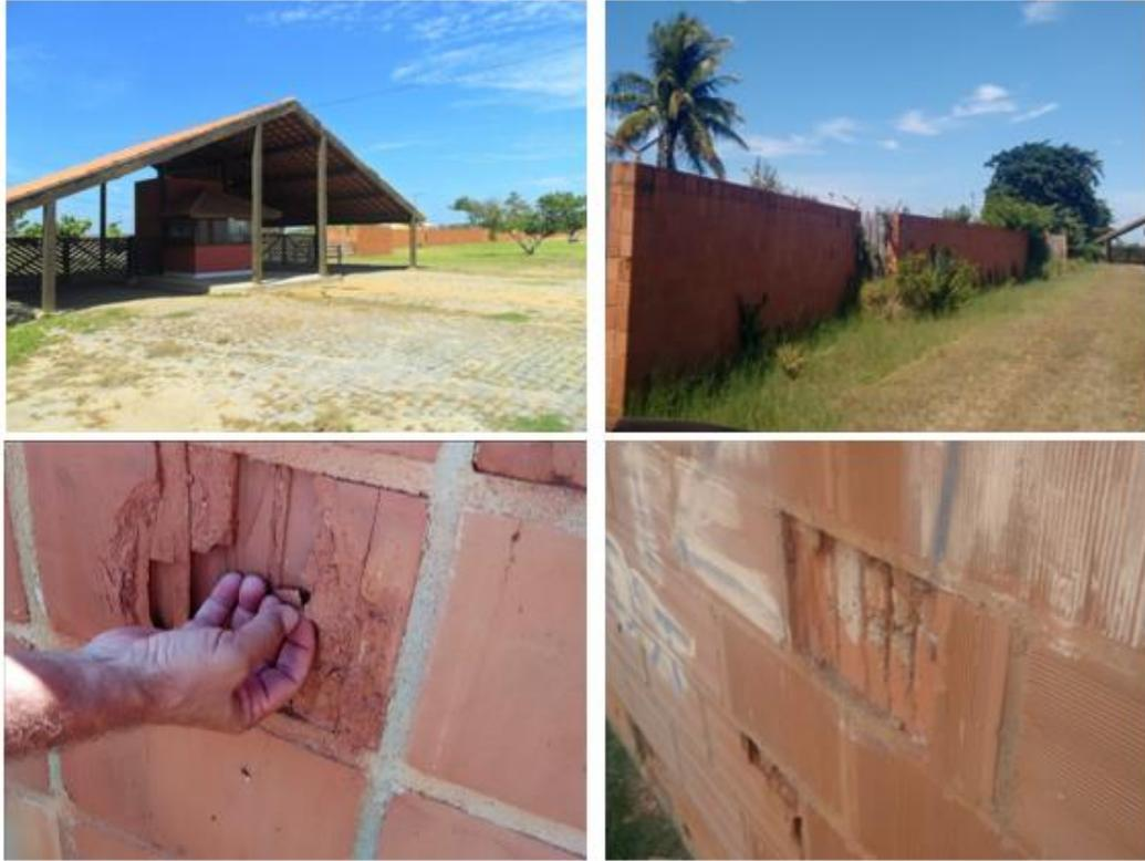
Figura 2.2 – Degradação em alvenaria em ambiente marinho – São João da Barra/RJ.
