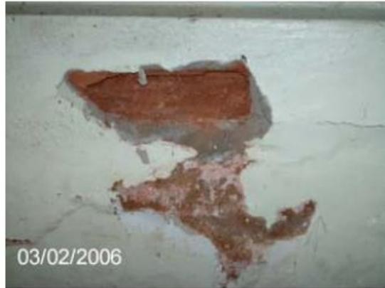
Figura 2 5 – Degradação rápida de alvenaria por ascensão de águas sulfatadas.
