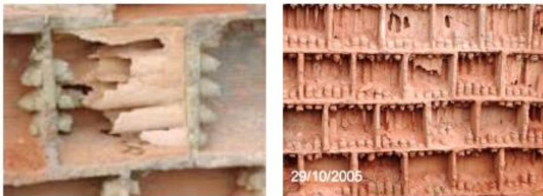
(a) Degradação rápida em alvenaria em ambiente marinho – Grussaí-RJ
