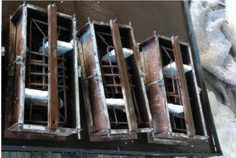
Figura 3.11 - Formas de push-off prontas para a concretagem
