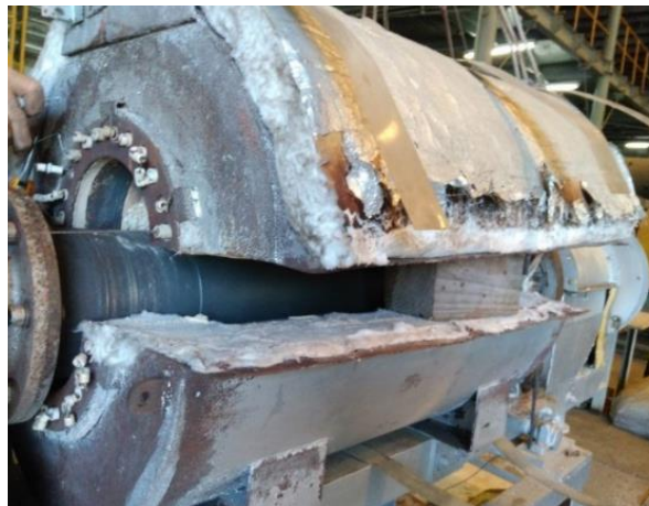
Figura 3.8 – Detalhe do corpo do reator e do revestimento do forno (ANDREÃO, 2018).
