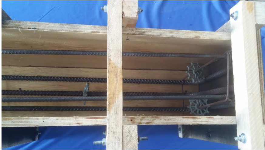
Figura 3.41 – Fixação das armaduras com espaçadores.
