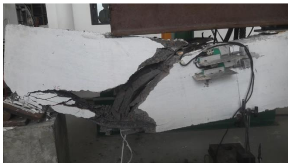
Foto 7 – Aspecto da viga V1_CLE.
