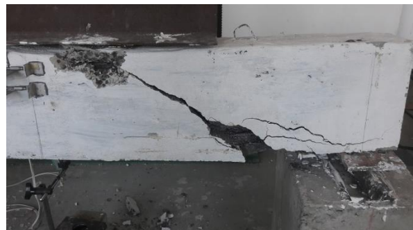
Foto 14 – Aspecto da viga V2_CLAA_100_00.
