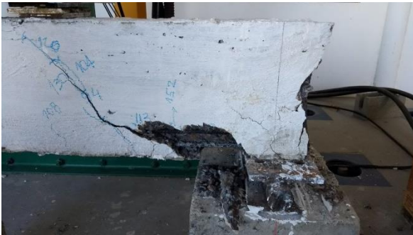
Foto 21 – Aspecto da viga V4_CLAA_70_30.
