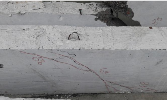
Foto 11 – Aspecto da viga V5_CLE.
