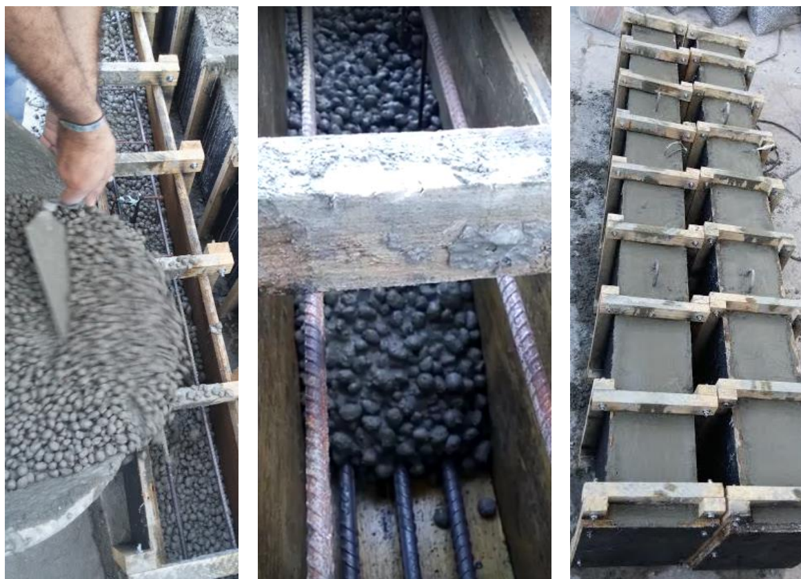
Figura 3.43 – A concretagem das vigas de CLAA dispensaram adensamento mecânico.
