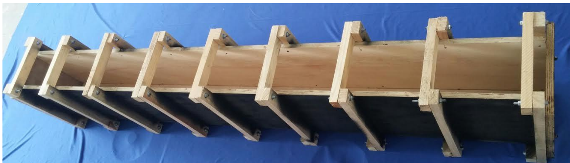
Figura 3.40 – Forma para concretagem das vigas.
