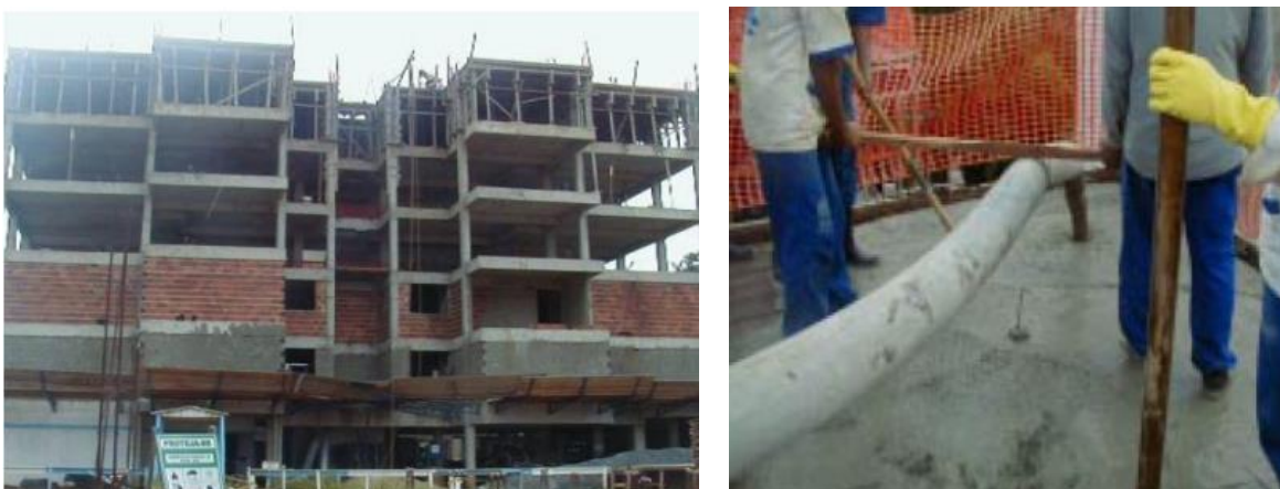
Figura 2.14 – Detalhe da estrutura e da concretagem do Edifício Camila em Goiânia (Silva, 2008).
