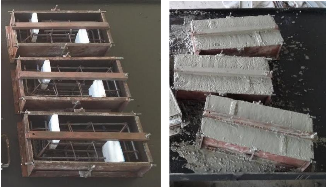
Figura 3.16 – Formas metálicas e moldagem dos corpos de prova do ensaio de push-off em mesa vibratória.
