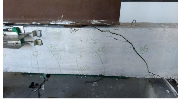
Foto 20 – Aspecto da viga V3_CLAA_70_30.
