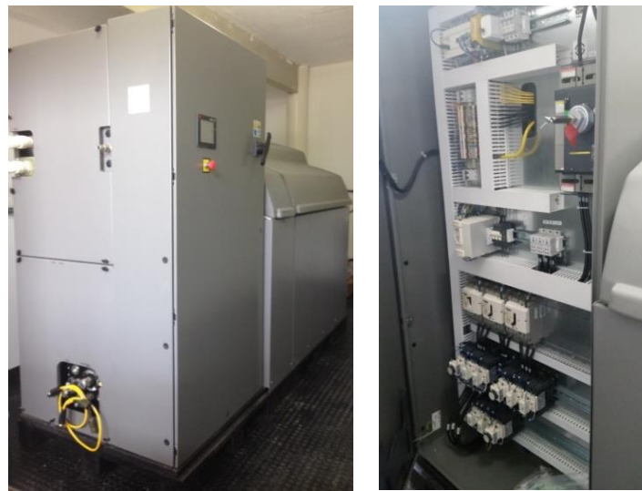
Figura 3.46 – Unidade hidráulica 505.90S da MTS.
