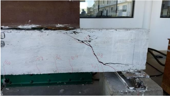
Foto 19 – Aspecto da viga V2_CLAA_70_30.
