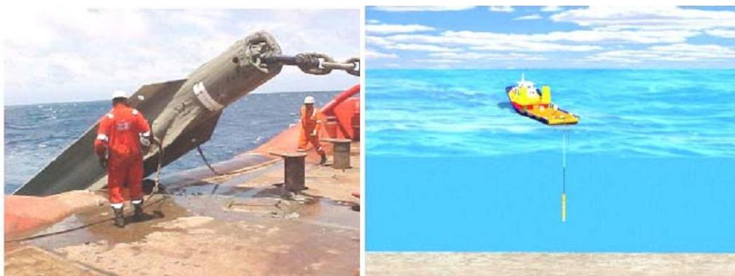
Figura 1.3 Lançamento da estaca torpedo (Boom et al., 2009)
