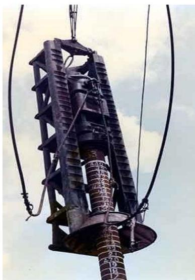
Figura 1.2 Martelo a vapor executando a cravação
