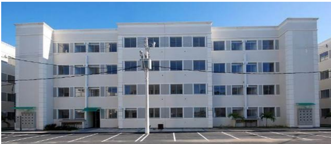
Figura 2 – Bloco do condomínio Parque Água Marinha em Campos dos Goytacazes/RJ, construído em alvenaria estrutural de blocos de concreto.
