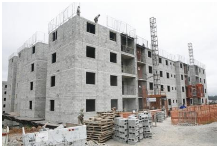
Figura 1 – Prédio de cunho popular em alvenaria estrutural de blocos de concreto.
