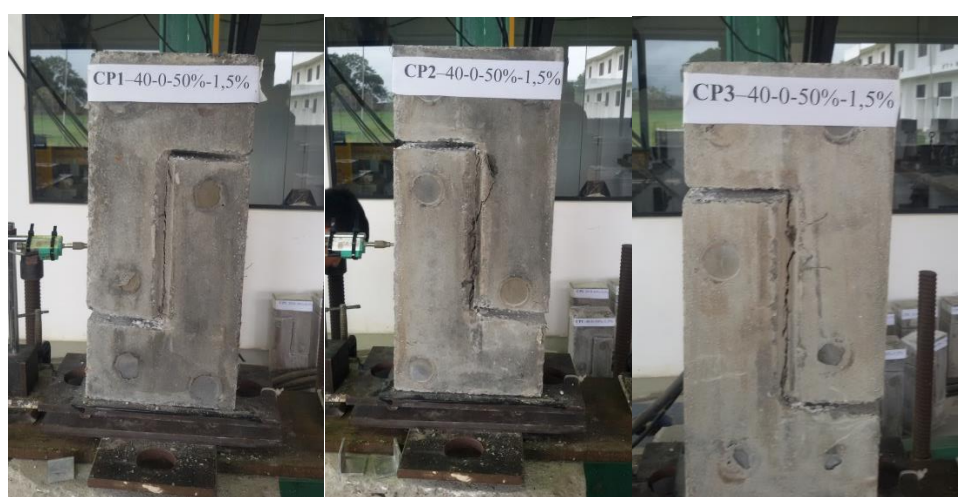
Figura 4.13 – Corpos de prova CPn 2 40-0-50-1,5 após da realização do ensaio push-off .
