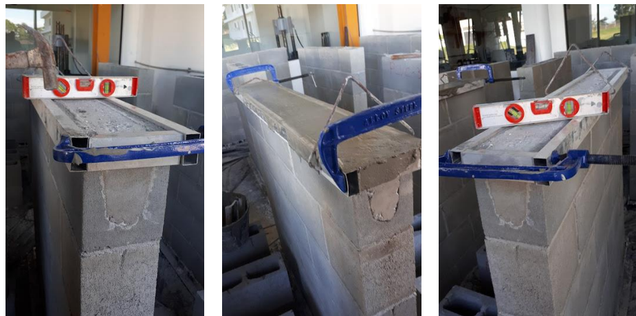
Figura 44 – Capeamento das paredes. Fonte: Próprio autor
