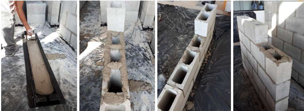
Figura 33 - Construção das Paredes. Fonte: Próprio autor
