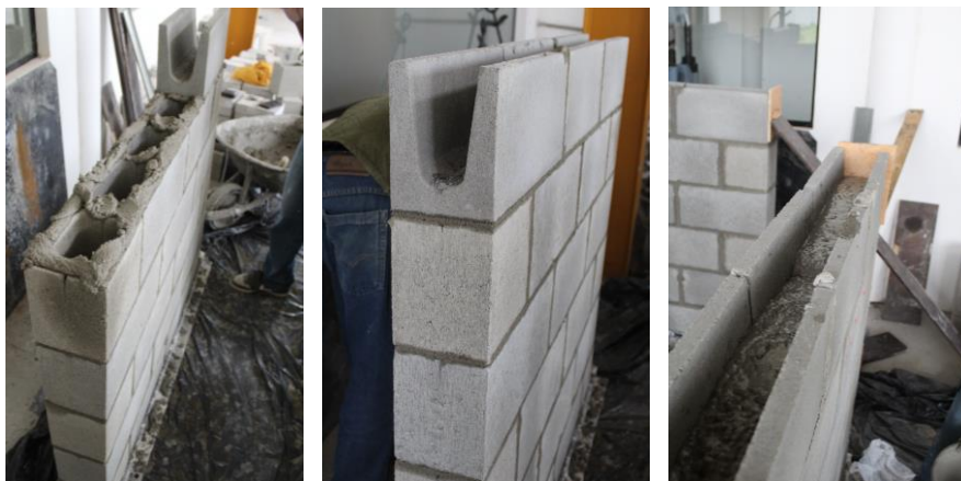
Figura 42 - Parede com viga. Fonte: Próprio autor
