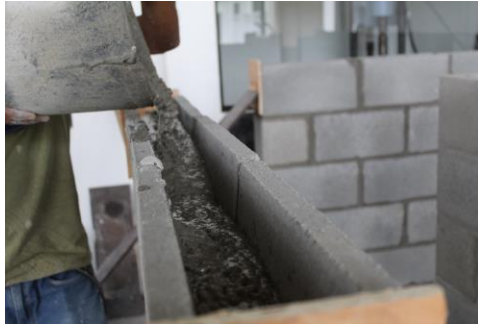
Figura 43 - preenchimento das vigas. Fonte: Próprio autor
