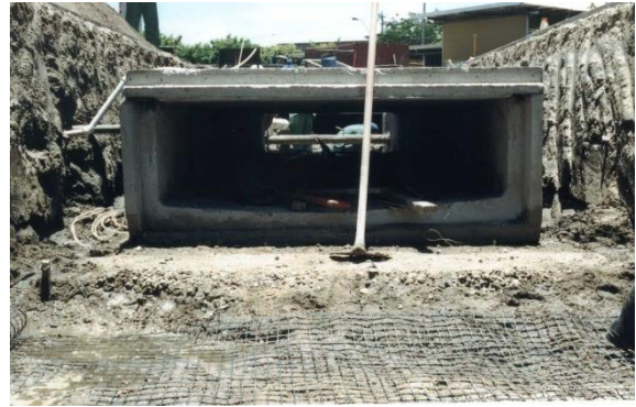
(b) Reforço de galerias (Brasil).
