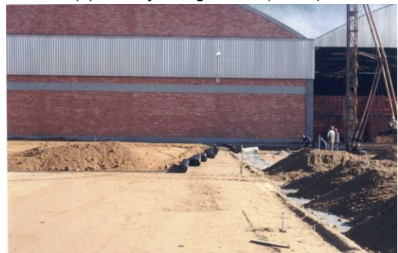
(d) Base de piso industrial (Brasil).
