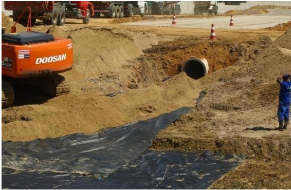
(a) Reforço de lastro de dutos (Brasil).
