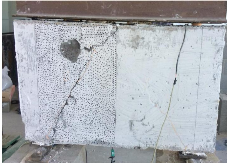
Figura 4.4: Ruptura da viga VCL054.
