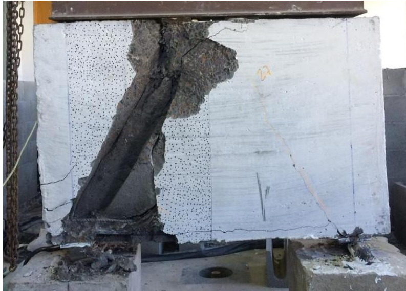
Figura 4.14: Ruptura da viga VCL057.
