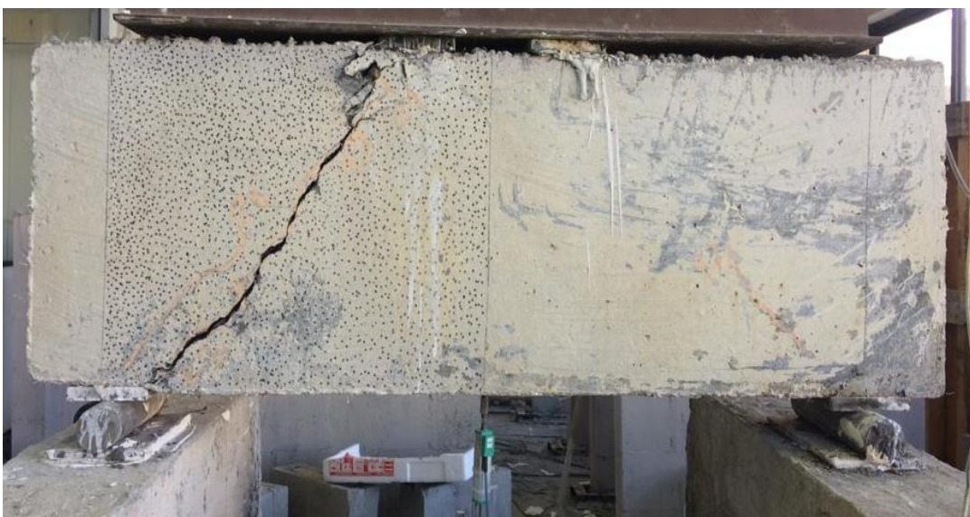
Figura 4.21: Ruptura da viga VCLF104.
