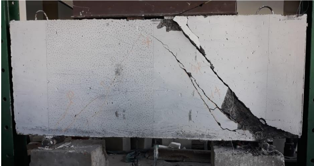
Figura 4.29: Ruptura da viga VCL087.
