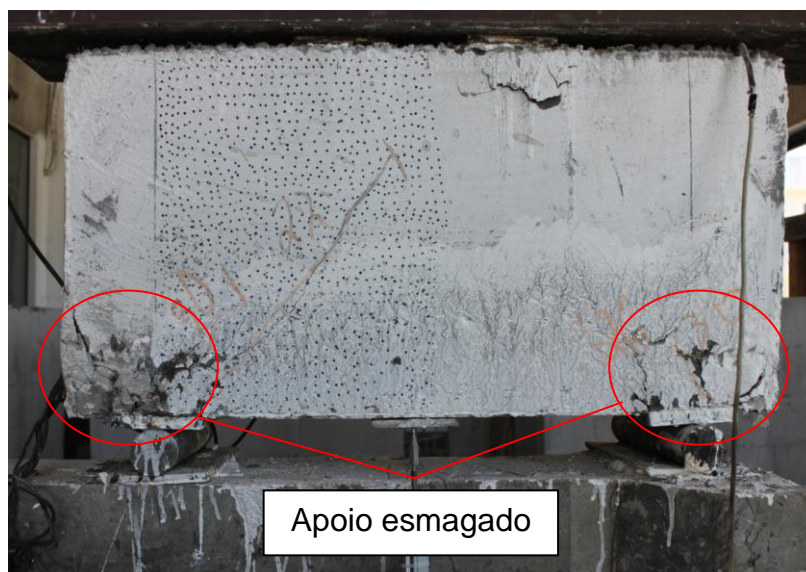
Figura 4.6: Ruptura da viga VCLF054.
