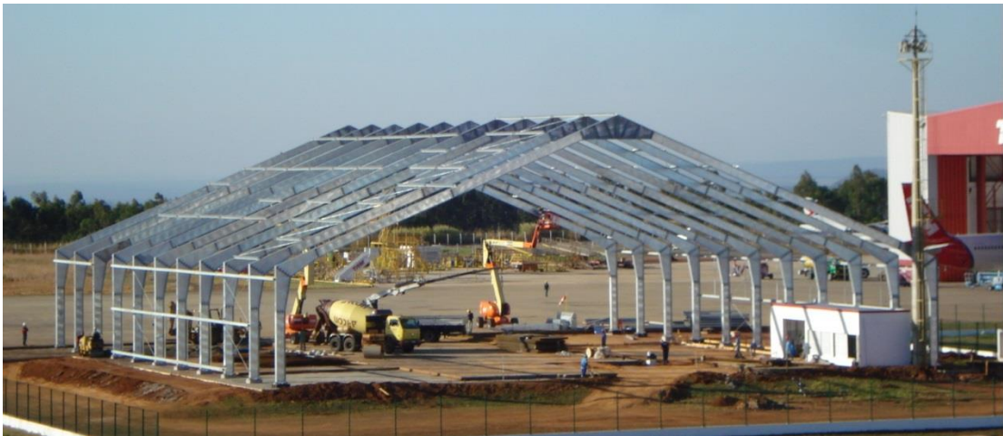
Figura 8: Pórtico estrutural de alma cheia
