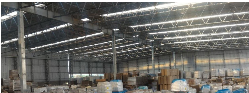
Figura 10: Pórticos metálicos com colunas centrais
