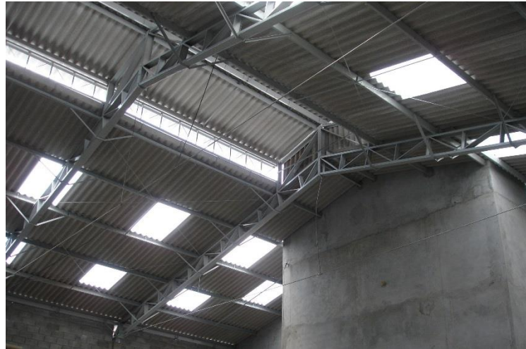
Figura 9: Pórticos metálicos com tirantes
