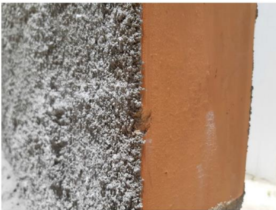
Figura 19 – Chapisco aplicado sobre substrato cerâmico (ZANELATO, 2019).
