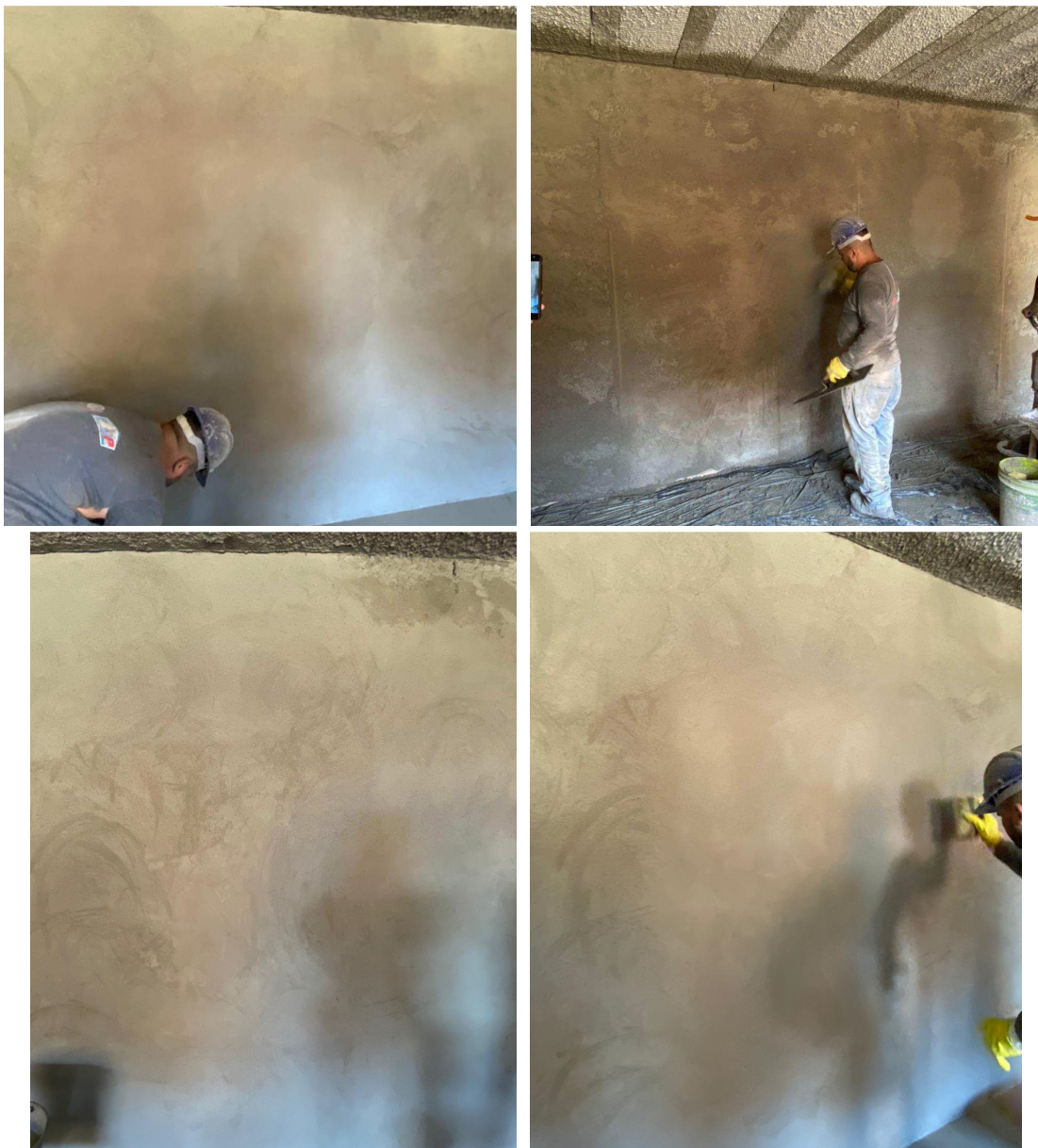
Figura 56 - Revestimento R01 aplicado em canteiro de obras em condições reais.
