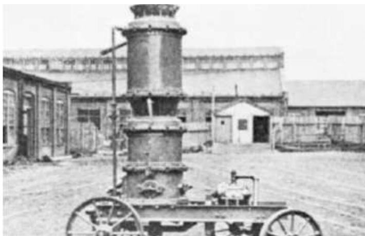
Figura 3 - Primeiro equipamento de projeção de argamassa inventado por Akeley.
