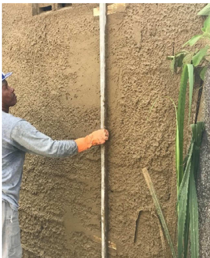
Figura 15 - Uso de taliscas como guia de controle na parte superior e inferior.
