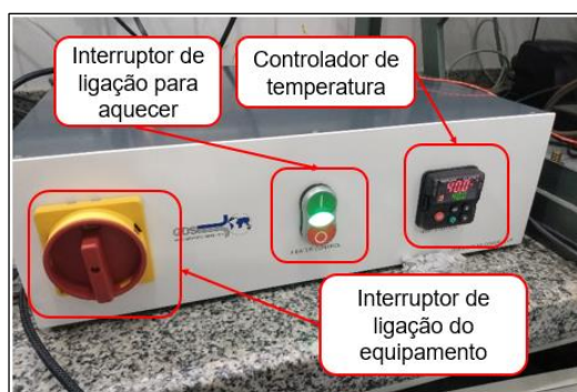
Figura 3.13: Sistema de controle de temperatura do laboratório da centrifuga geotécnica – UENF.
