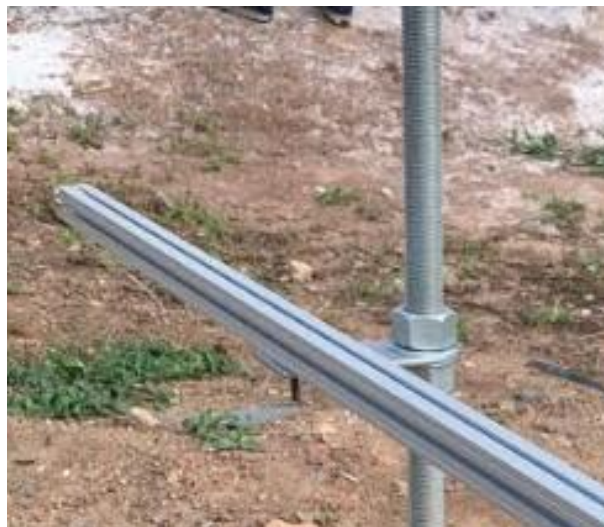
Figura 30 - Viga de referência com apoio fixo
