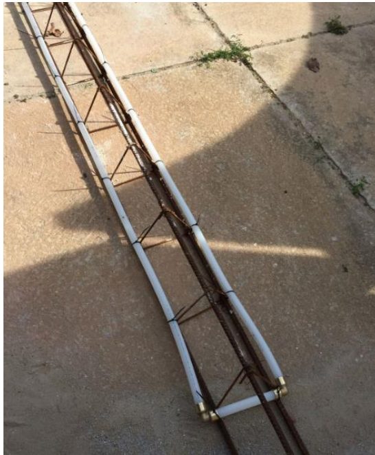
Figura 19 - Tubo PEX trocador de calor em forma de "U" preso a armadura da estaca.
