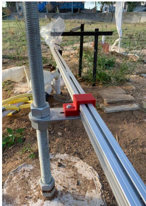
Figura 32 - Viga de referência com apoio móvel.
