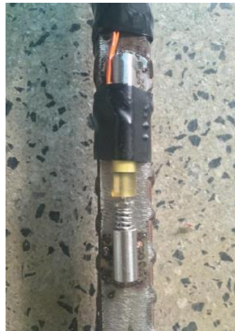
Figura 21 - Strain Gauge instalado na armadura
