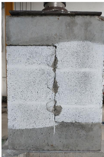
Figura 103 – Corpo-de-prova de junta seca com três dentes de cisalhamento rompida.
