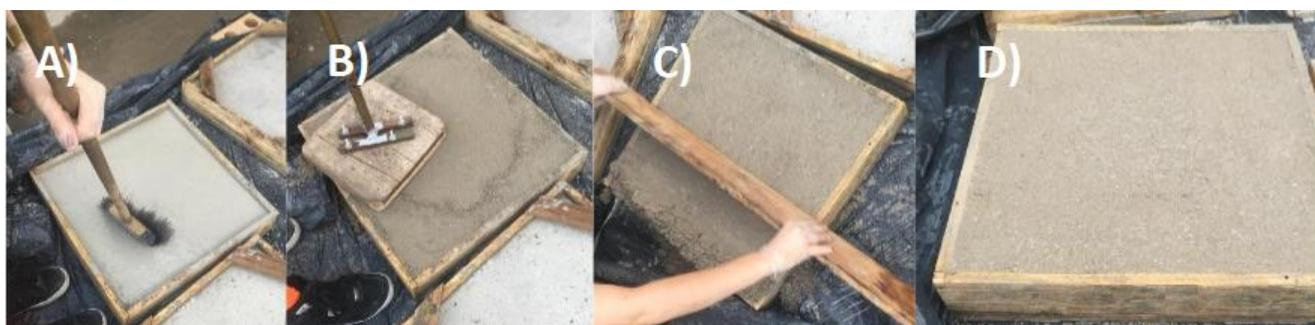
Figura 47 - Passo-a-passo da execução do contrapiso: A) Polvilho de cimento; B) Compactação do contrapiso com soquete de madeira; C) Sarrafeamento; D) Contrapiso pronto
