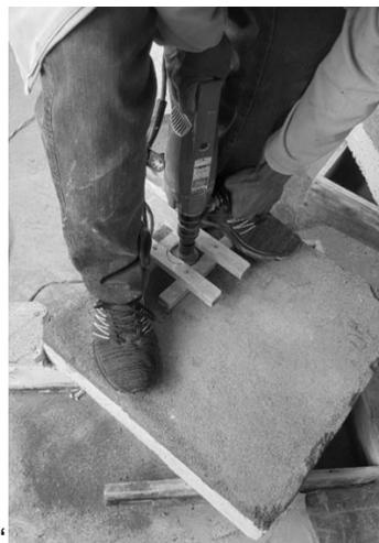
Figura 34 - Cortes nas argamassas sendo realizados com serra copo
