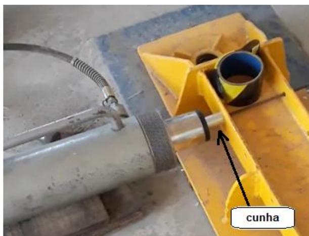
Figura 3-9 - Detalhe da posição do cilíndrico hidráulico de protensão e da cunha.
