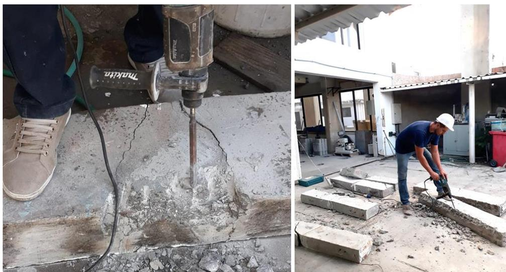
**Figura 3-34 – Processo de extração dos fios das viga**
