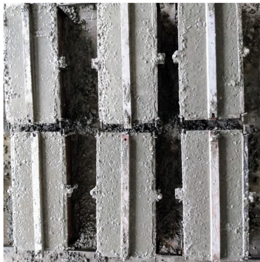
Figura 3.26: Espécimes após a concretagem.
