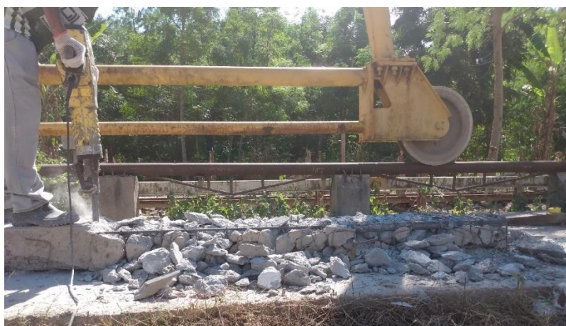
Figura 3.3: Fragmentação da viga pré-moldada com auxílio de um martelete.
