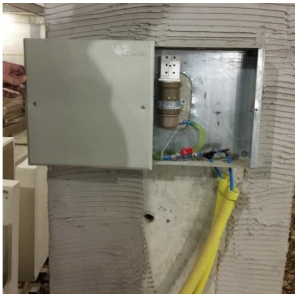
Novo instrumento instalado no canteiro de obra
