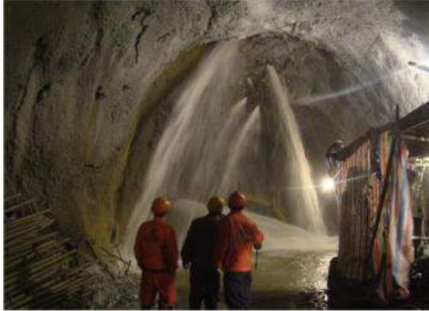
Figura 2.4 Entrada de fluxo de água durante a escavação do túnel (Chunsheng Zhang et al., 2016).
