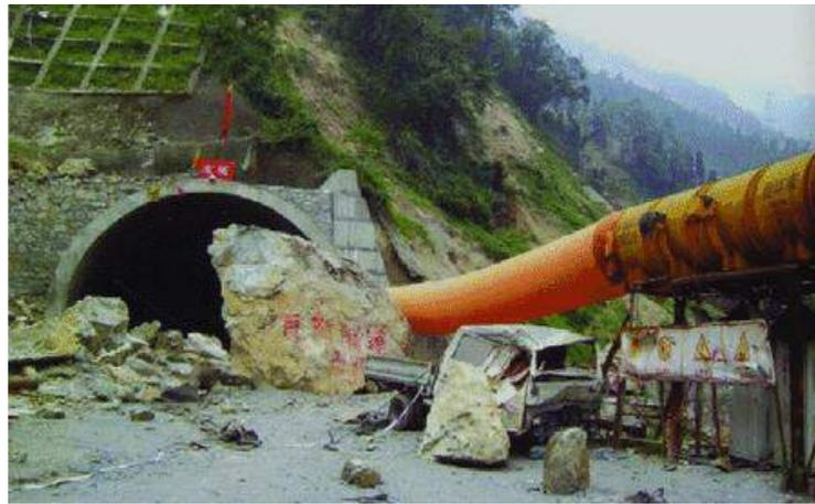
Figura 2.5 Ruptura do portal durante o terremoto de Wenchuan 2008 – Túnel de Longxi (Tsinidis et al., 2020).
