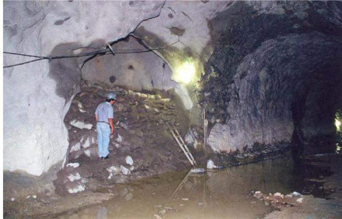
Figura 2.2 Colapso subterrâneo de parede lateral (Seidenfuss, 2006).
