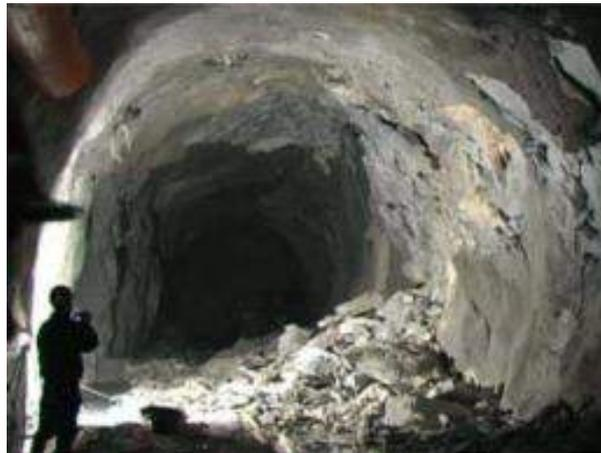
Figura 2.3 Colapso por *rock burst* (He et al., 2012).
