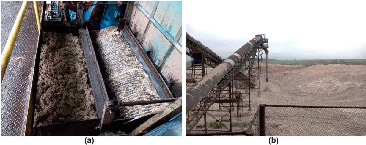
Figura 11: Saída do bagaço para as esteiras de alimentação da caldeira (a) e armazenamento do bagaço de cana-de-açúcar (b).
