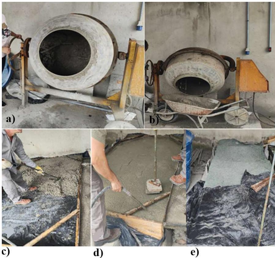
Figura 23: Etapas da concretagem da laje para produção dos AR (a) mistura, (b) transporte, (c) lançamento, (d) adensamento e (e) cura.
