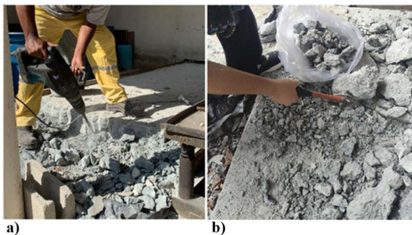
Figura 27: Fragmentação do concreto para produção de agregado reciclado
