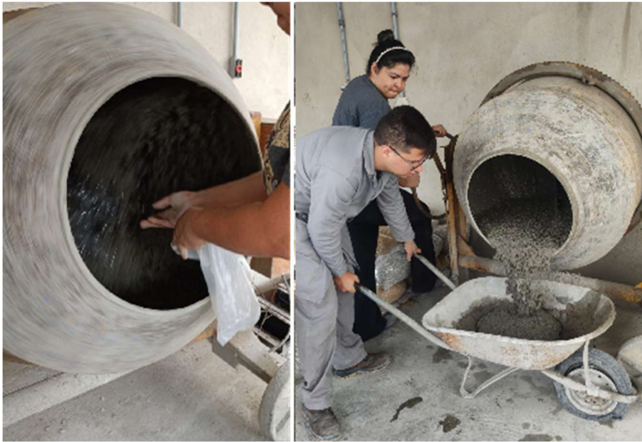
Figura 41: Processo de produção dos concretos para as vigas
