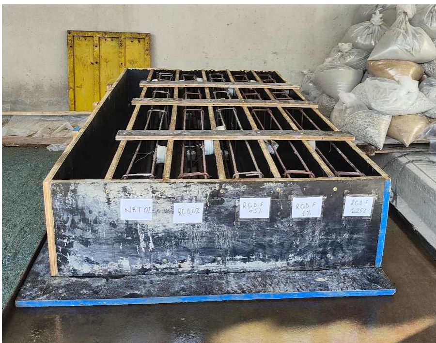
Figura 38: Montagem das formas para molde das vigas
