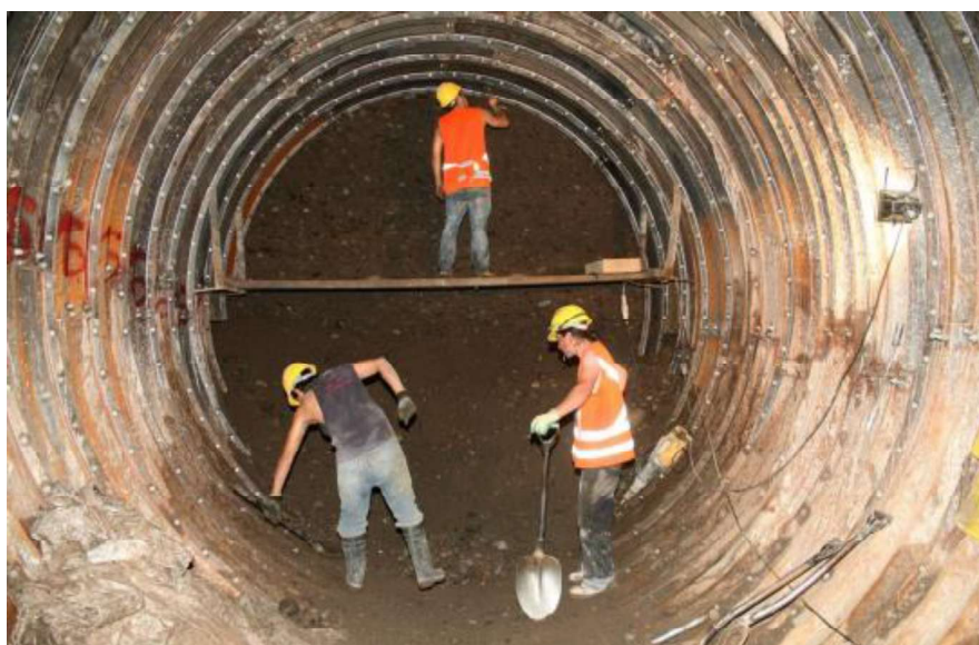
Figura 9 - Método de escavação "Tunnel Liner" (cintac 2014).
