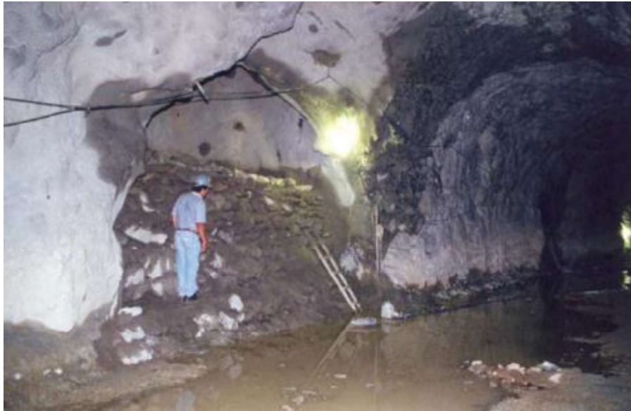
Figura 2 - Colapso subterrâneo (Seidenfuss, 2006).
