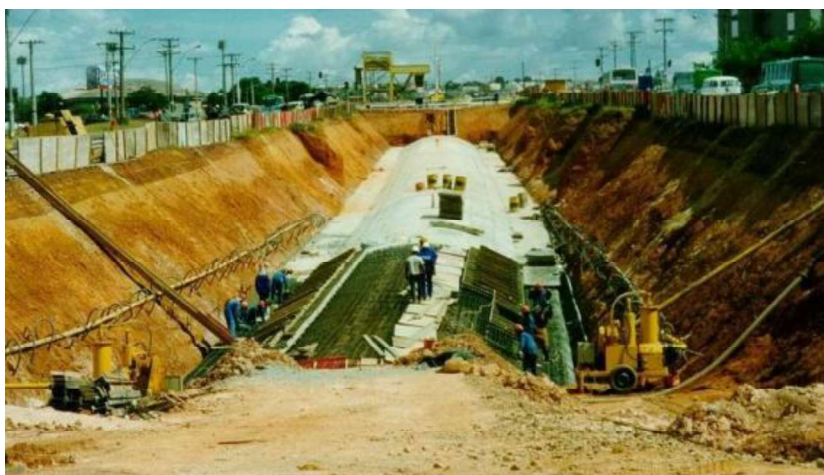
Figura 7 - Método de construção a céu aberto. Metrô de Brasília-DF (Assis, 2013).
