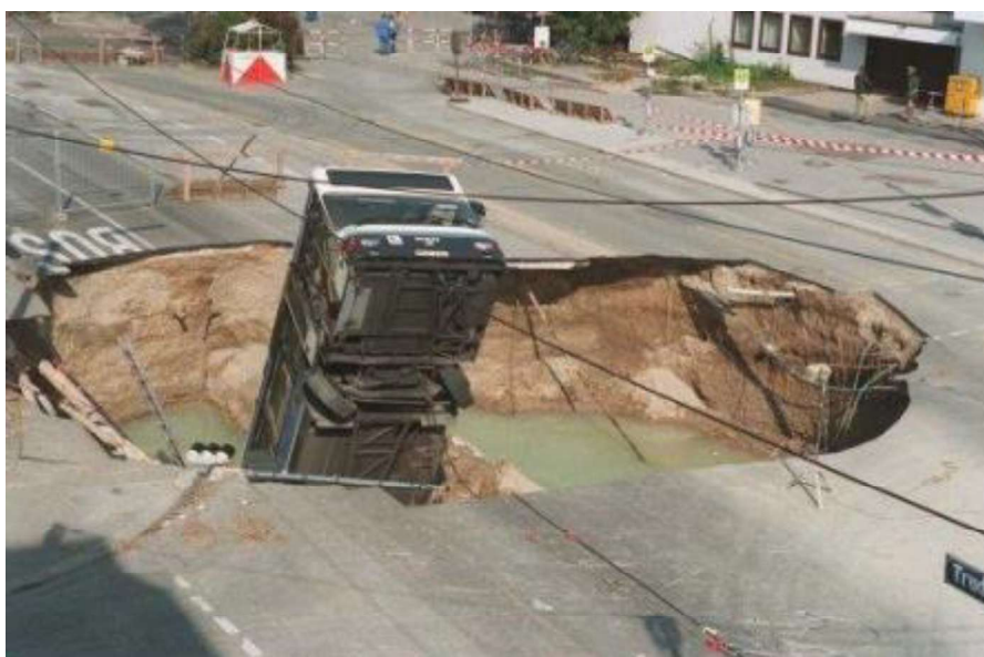
Figura 1 - Colapso com afloramento em Munique, Alemanha 1994 (Seidenfuss, 2006).
