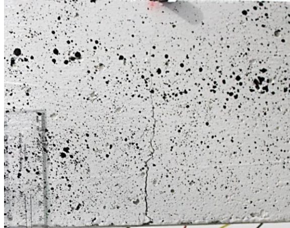
Figura 100 – Viga MB-1-5 após ensaio de flexão.
