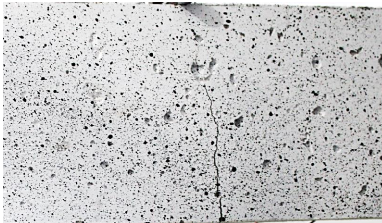
Figura 98 – Viga MB-0,5-5 após ensaio de flexão.
