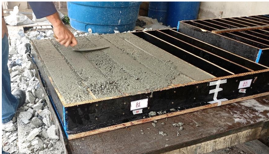
Figura 37 – Moldagem das vigas (MA-R).
