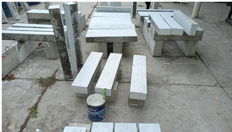
Figura 41 – Aplicação de tinta branca nas vigas.
