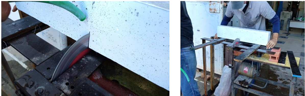
Figura 43 – Processo de entalhe das vigas.
