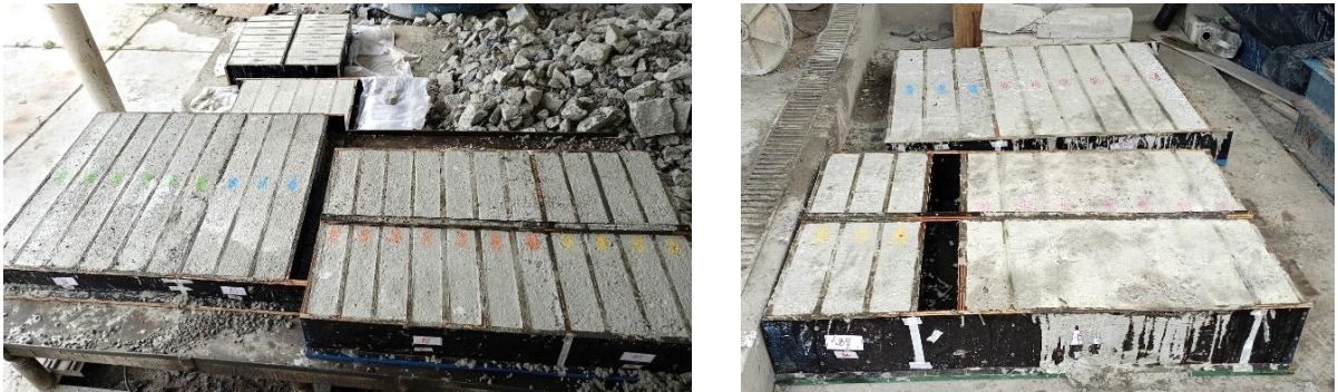
Figura 39 – Vigas após 24h da concretagem.
