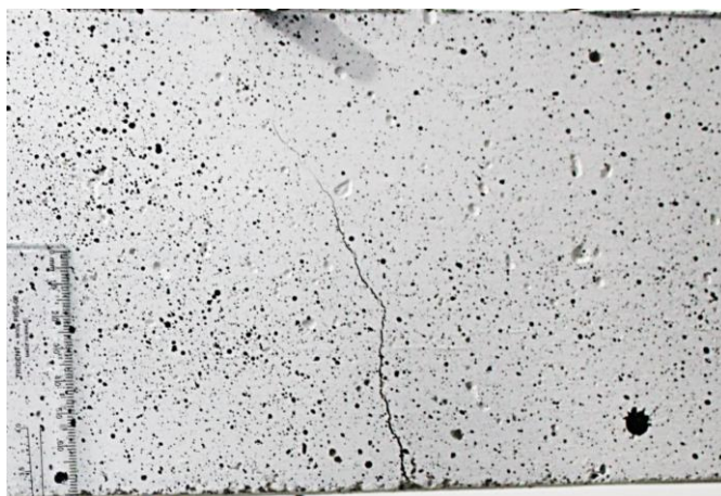
Figura 102 – Viga MB-1,25-5 após ensaio de flexão.
