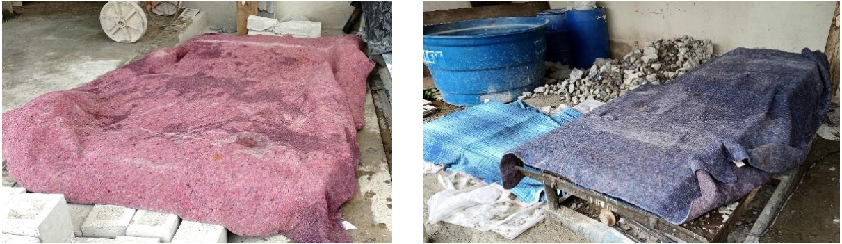
Figura 38 – Processo de cura inicial do concreto.
