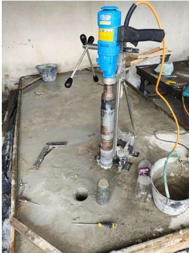
Figura 9 - Extração dos testemunhos da laje moldada pra confecção dos ARC.
