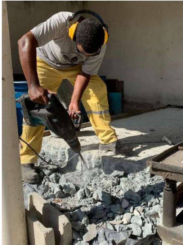
Figura 10 - Processo de fragmentação da laje para produção do ARC.
