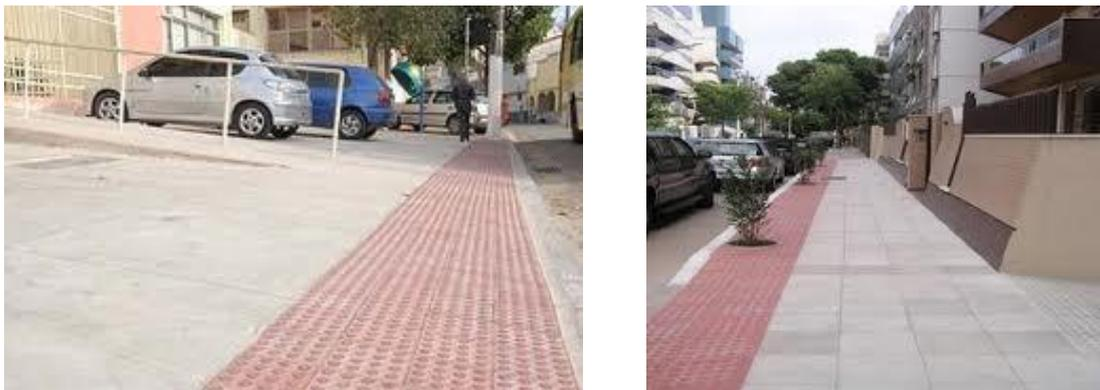
**Figura 3.10 – Calçada com a utilização do ladrilho hidráulico piso tátil.**
